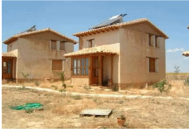
Vivienda construida con blocks de adobe.
