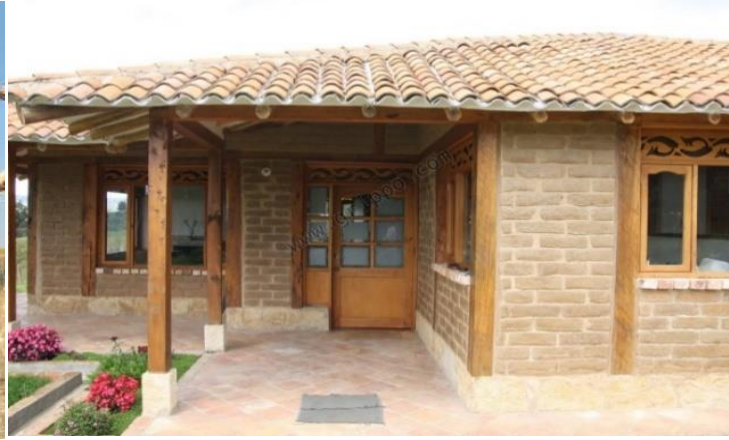
Vivienda construida con adobe.
