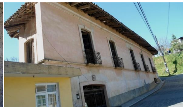
Autor: Sonderegger Suárez Arantxa (2014). Tipología de la vivienda de dos niveles, predominio de macizo sobre vano y enmarcamiento de piedra en vanos con balcones.
