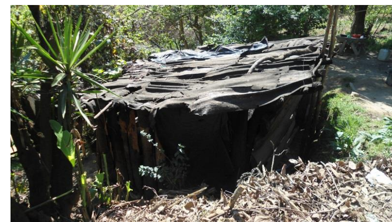
Autor: Sonderegger Suárez Arantxa (2014). Vivienda construida con lámina de cartón y muros de madera.
