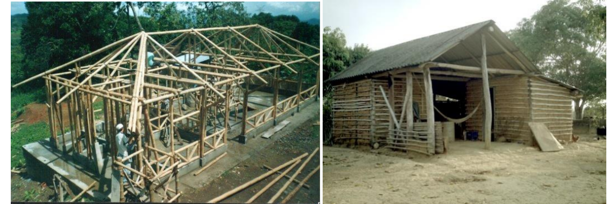
Estructura de una vivienda de muros de bahareque.
