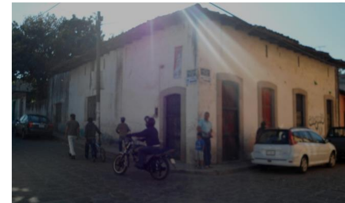
Autor: Sonderegger Suárez Arantxa (2014). Vivienda con enmarcamientos de piedras en vanos y alero de madera.
