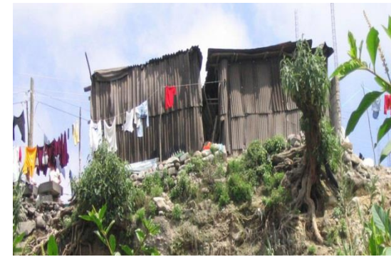
Vivienda de muros y techo de lámina de cartón.
