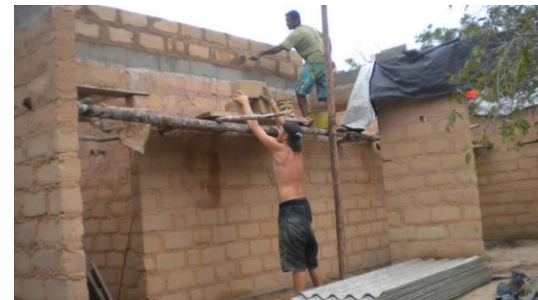
Construcción de vivienda hecha de adobe.
