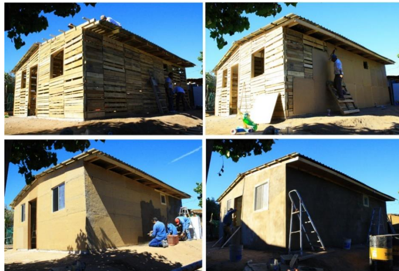
Construcción de casa con paneles de madera.
