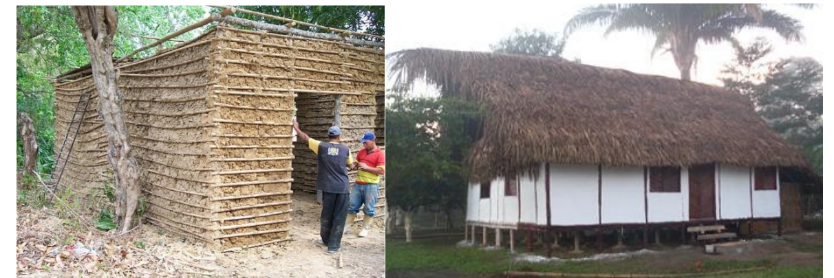
Construcción de casa de bahareque.
