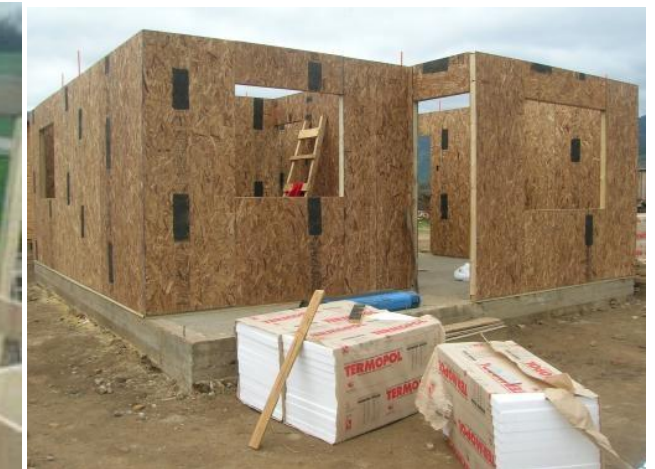
Montaje de paneles de madera.
