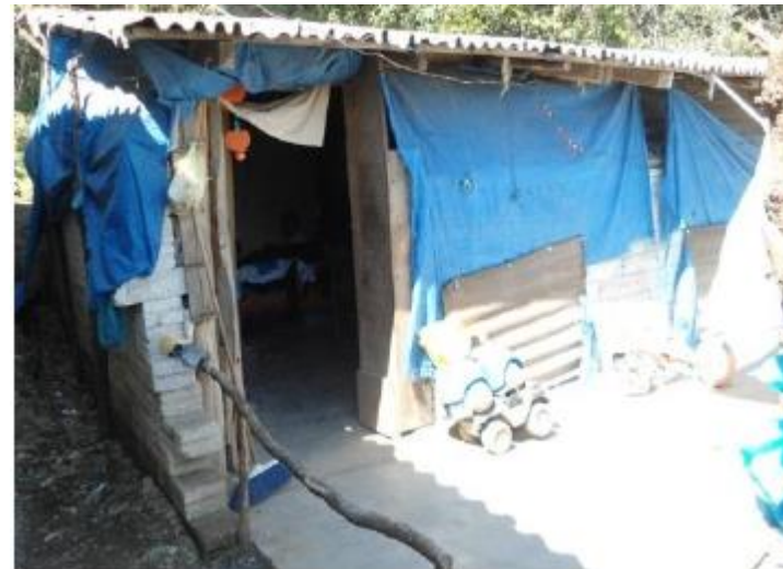
Autor: Sonderegger Suárez Arantxa (2014). Vivienda de blocks sobrepuestos sostenidos con palos de madera y lona plástica.
