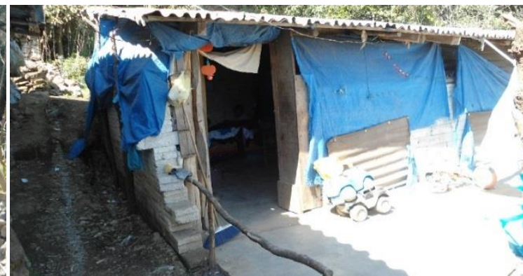
Autor: Sonderegger Suárez Arantxa (2014). Vivienda de blocks sobrepuestos, sostenidos con palos de madera y cubierta con lona plástica, techumbre de lámina a dos aguas.
