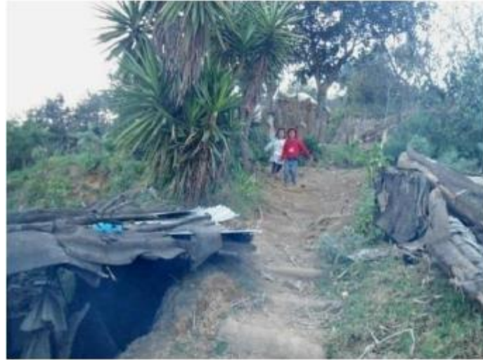
Autor: Sonderegger Suárez Arantxa (2014). Vivienda en condiciones precarias.
