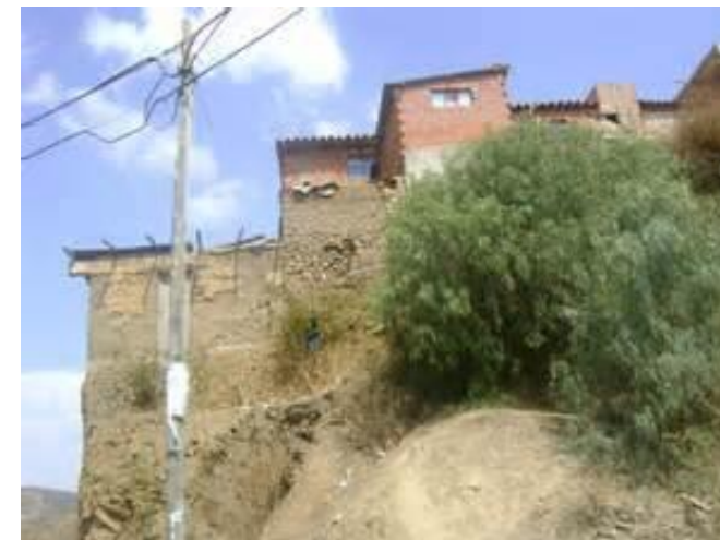
Viviendas ubicadas en zonas de alto riesgo.
