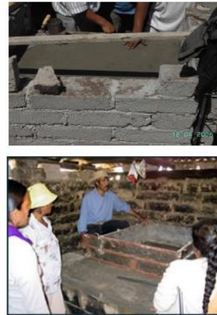
Base resistente sobre piedra.
