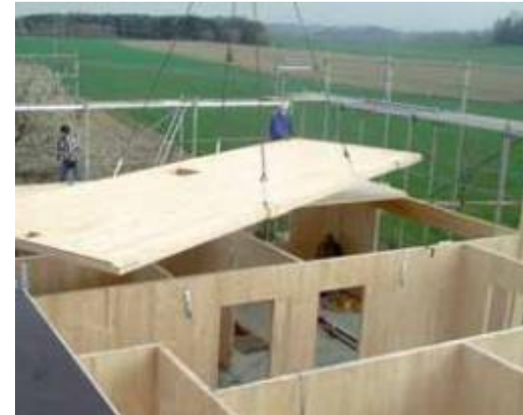
Montaje de paneles de madera.
