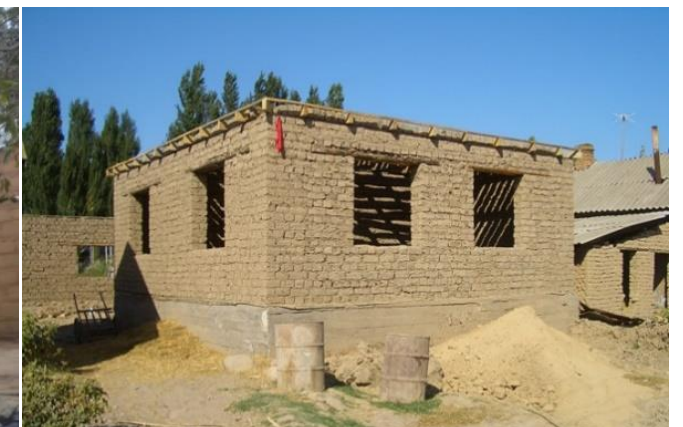
Vivienda construida con blocks de adobe.
