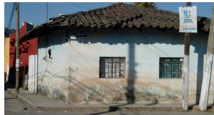
Autor: Sonderegger Suárez Arantxa (2014). Vivienda con predominio del macizo sobre el vano y techumbre a 4 vertientes.
