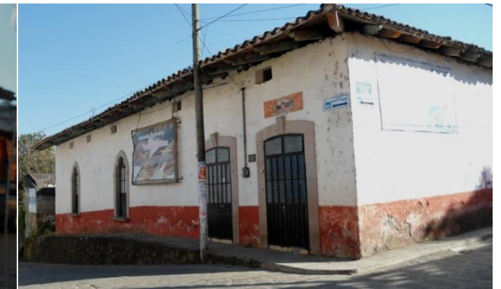
Autor: Sonderegger Suárez Arantxa (2014). Vivienda con enmarcamientos de piedras en vanos y alero de madera.
