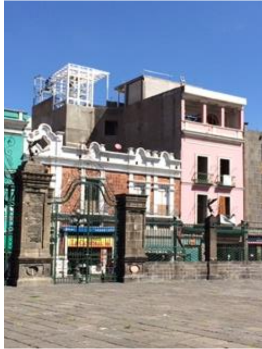
Fotografía propia tomada desde el atrio de la Catedral. Construcción nueva en proceso sobre la azotea, excediendo el perfil y alturas originales para la ampliación vertical de hotel, restaurante y terraza-bar en la 16 de Septiembre 303, frente a catedral. Fecha: 26 de junio de 2006.
