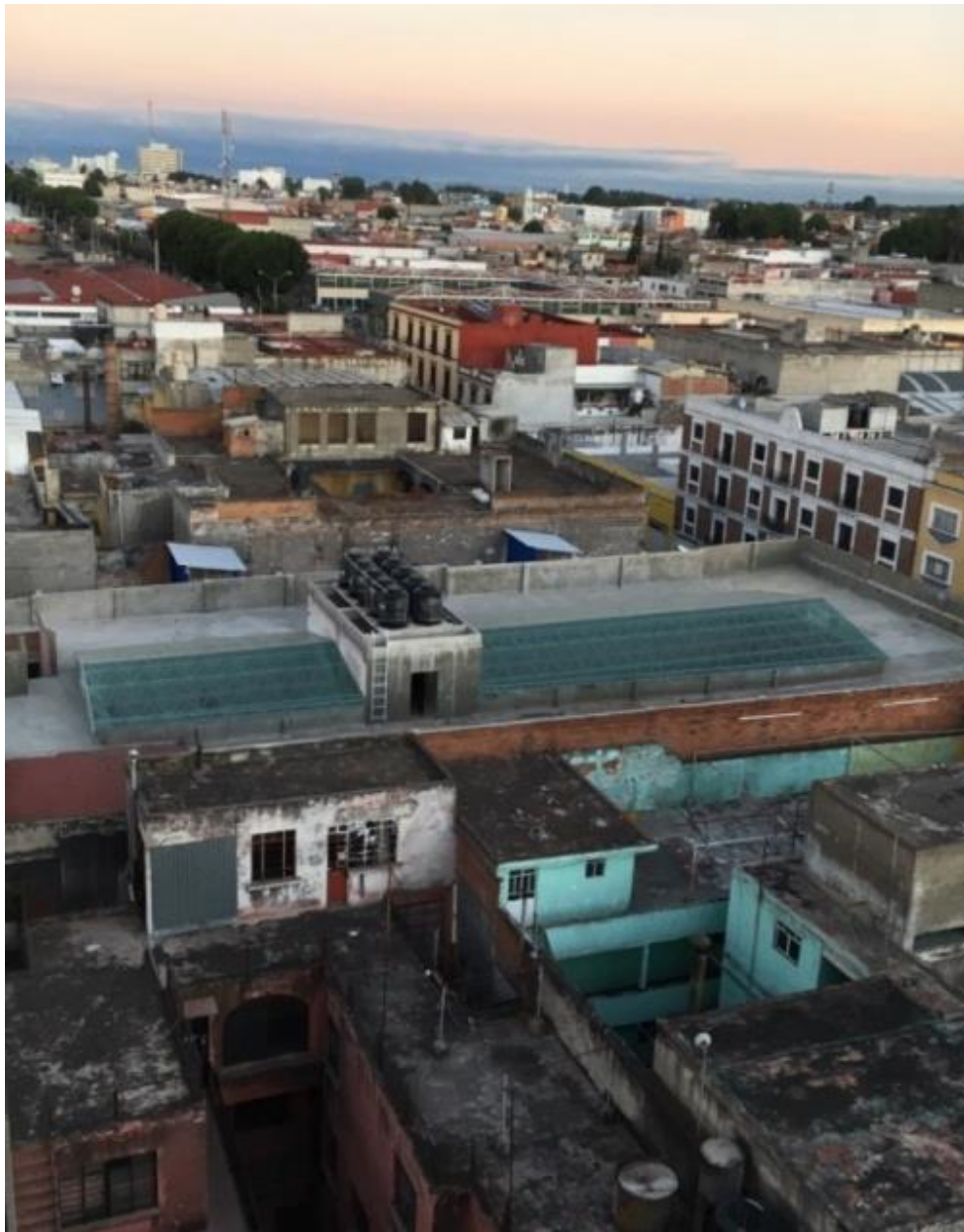
Fotografía propia. 4 poniente 905. Deterioro, restauración y habilitación para el turismo.
