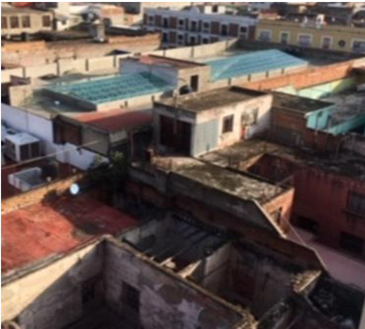
Foto propia, Rehabilitación de casas. 4 Poniente 905.
