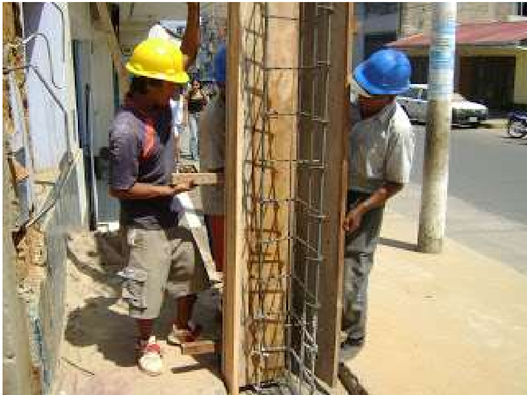
CIMBRADO DE COLUMNA
