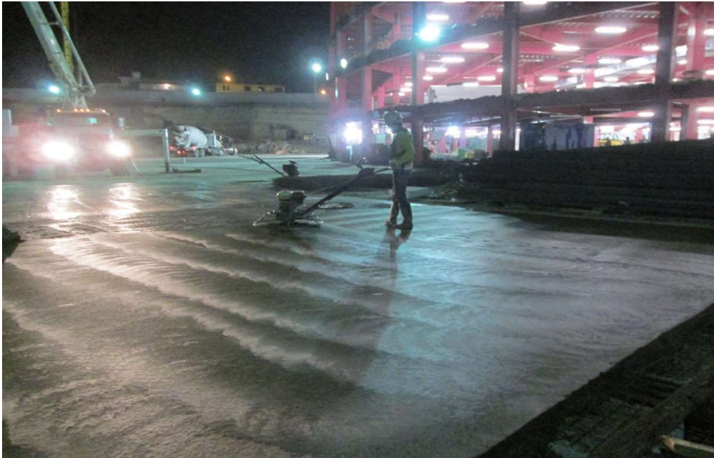
ACABADO PULIDO EN LOSA DE COMPRESION
