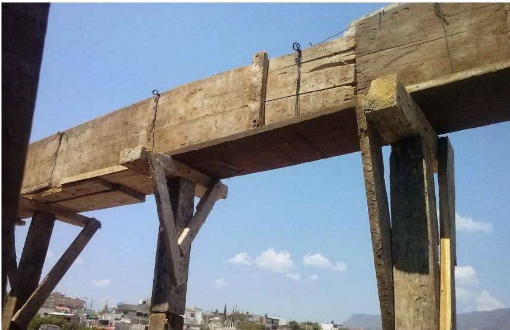
CIMBRADO DE TRABE
