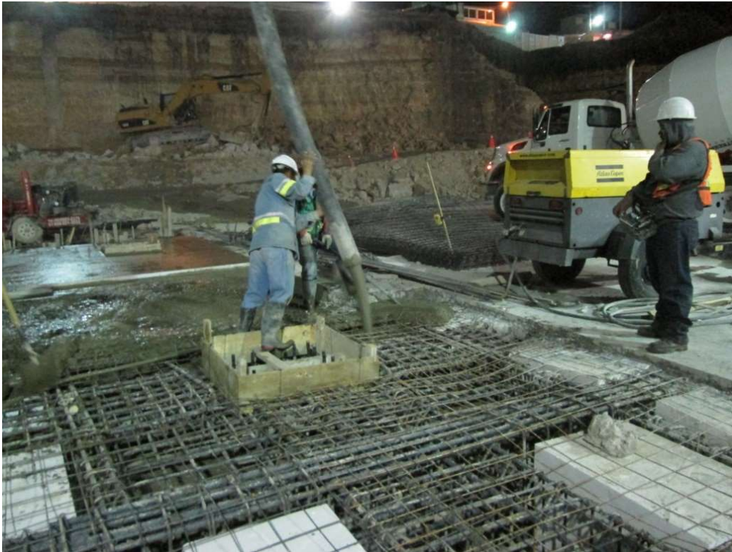
COLADO DE LOSA DE COMPRESIÓN
