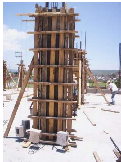
ENCOFRADO MADERA EN COLUMNA
