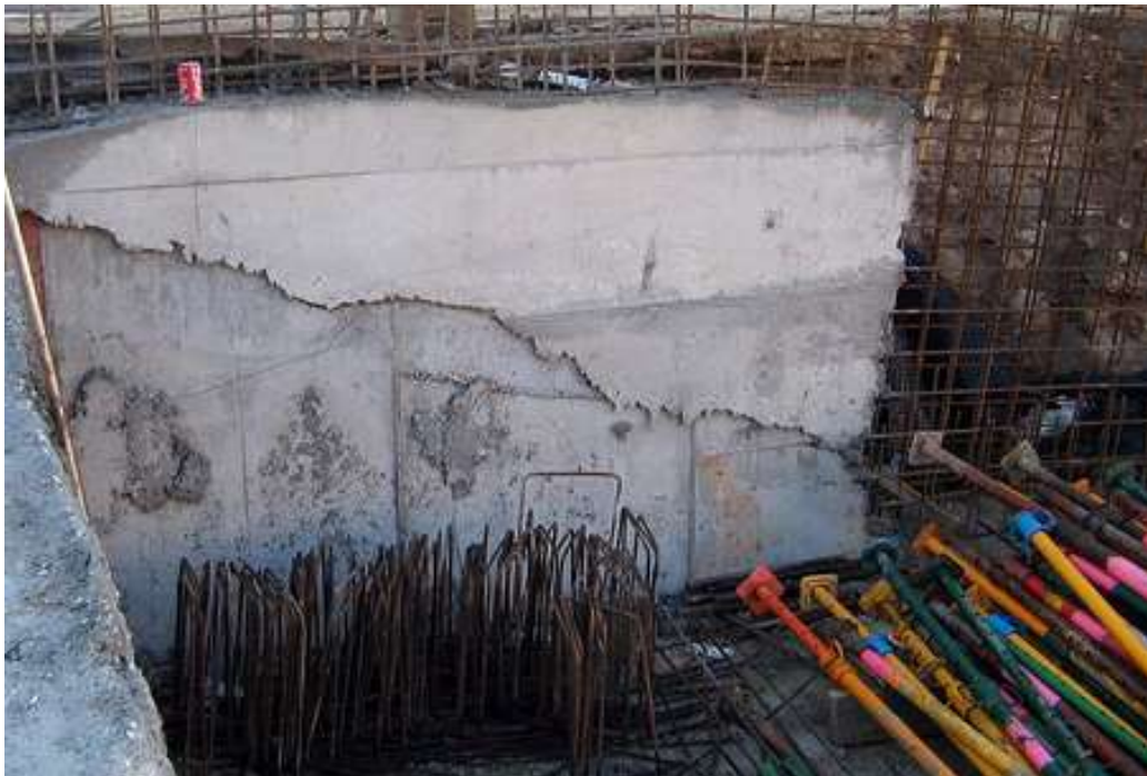
JUNTA FRÍA EN COLDADO DE MURO
