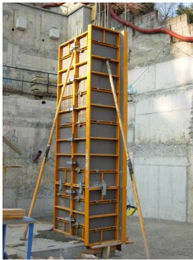
CIMBRA METALICA COLUMNA
