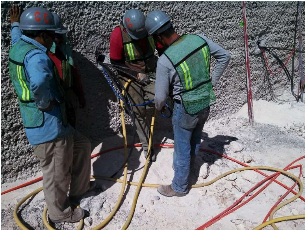
INYECCION DE CONCRETO PARA ANCLAS
