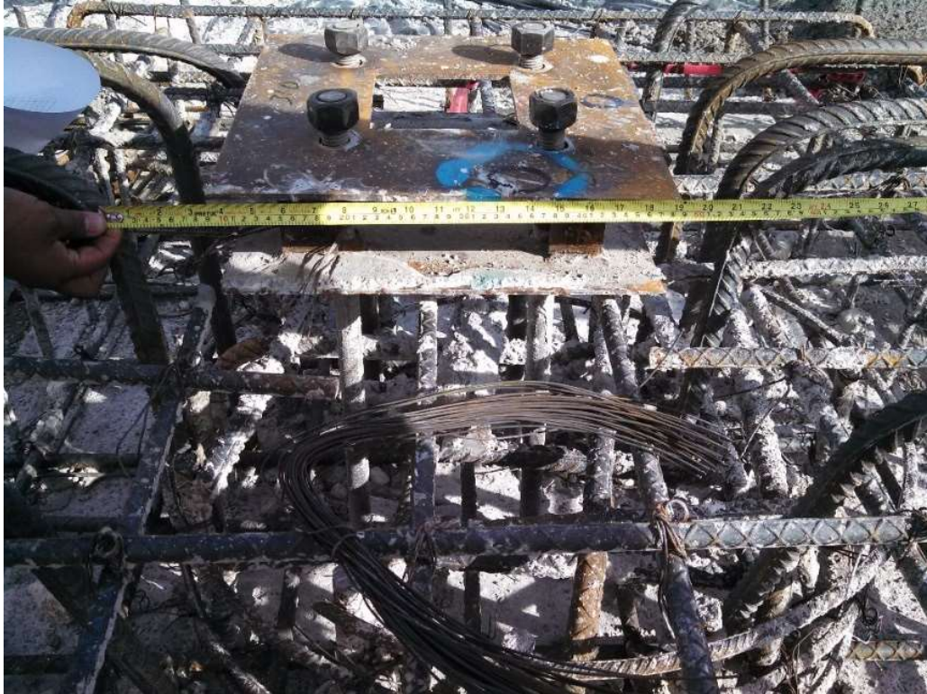
MEDICION SEPARACION DE ACERO DE REFUERZO
