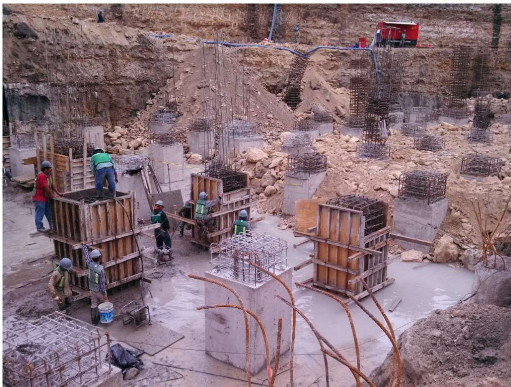
COLADO DE DADOS PARA DESPLANTE DE COLUMNAS
