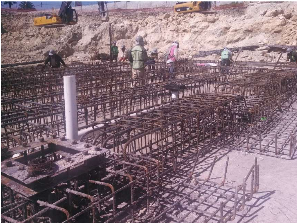
COLOCACION DE TUBERIA SANITARIO EN LOSA DE COMPRESION
