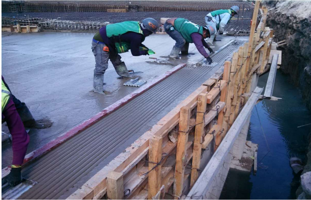
ACABADO ESTRIADO EN RAMPA DE ESTACIONAMIENTO
