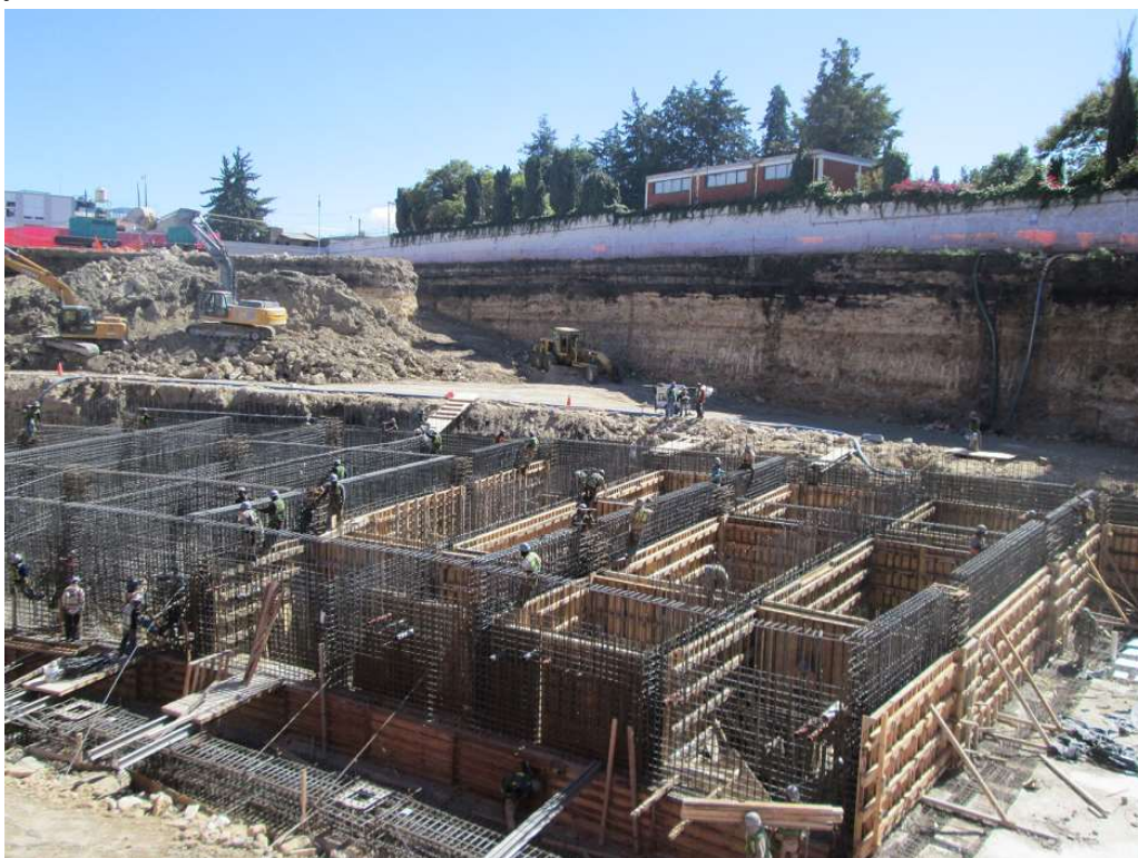
CIMBRADO DE MUROS PARA CISTERNA
