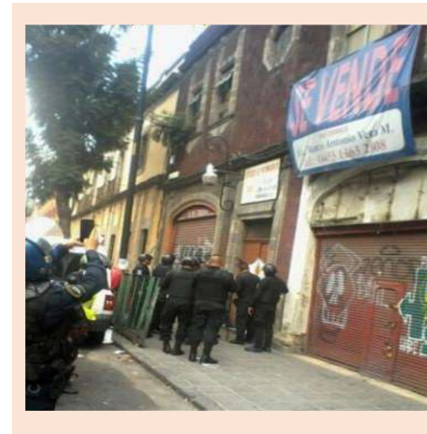
Imagen 0.1 Fachada principal del inmueble
