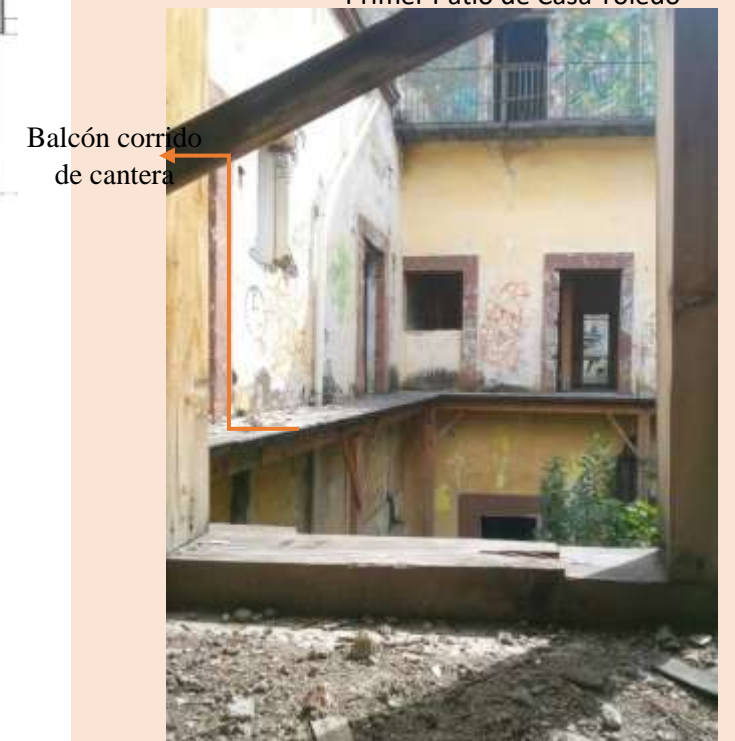
Imagen 2.2.4 Primer Patio de Casa Toledo
