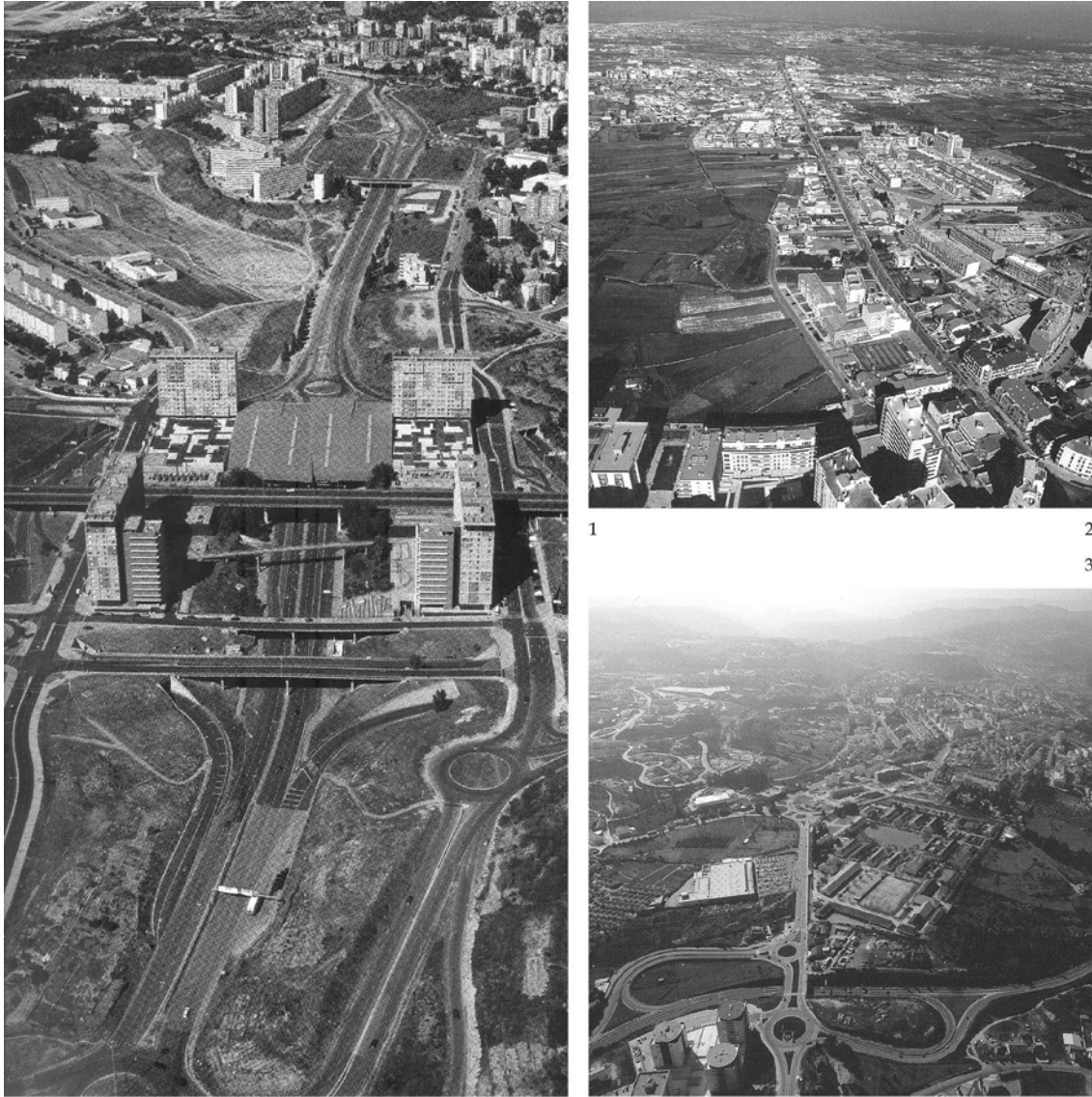
Fig. 01 - Fotografías de infraestructuras de movilidad y relaciones con fragmentos de tejido urbano adyacente. Fuente: © Filipe Jorge (Domingues, 2006). 1. Avenida Marechal António de Spínola . Lisboa 2. Carretera N13 . Póvoa de Varzim; 3. Carretera IP4 . Vila Real
