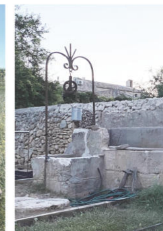
Pozo privado de greixina. cronología: siglo XIX profundidad: desconocida
