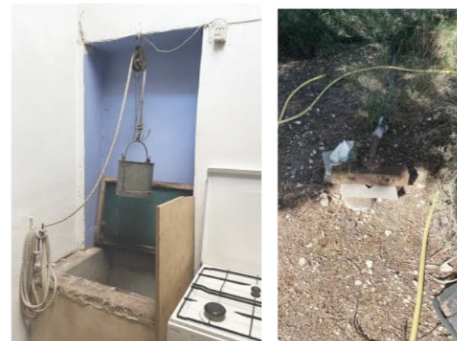
Cisterna de recogida de pluviales. Pozo por perforación.
