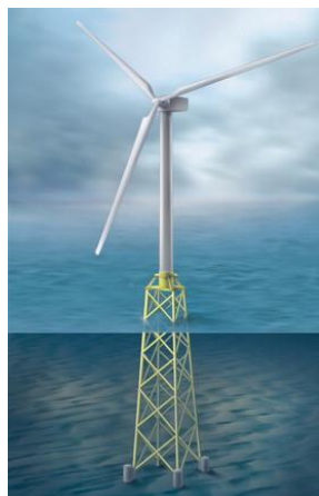
Figura 8: Representación en 3D de aerogenerador offshore tipo "Jacket"-Fuente: Reliability Engineering & System Safety
