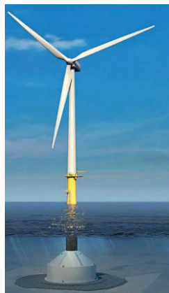
Figura 9: Representación en 3D de aerogenerador offshore basado en gravedad
