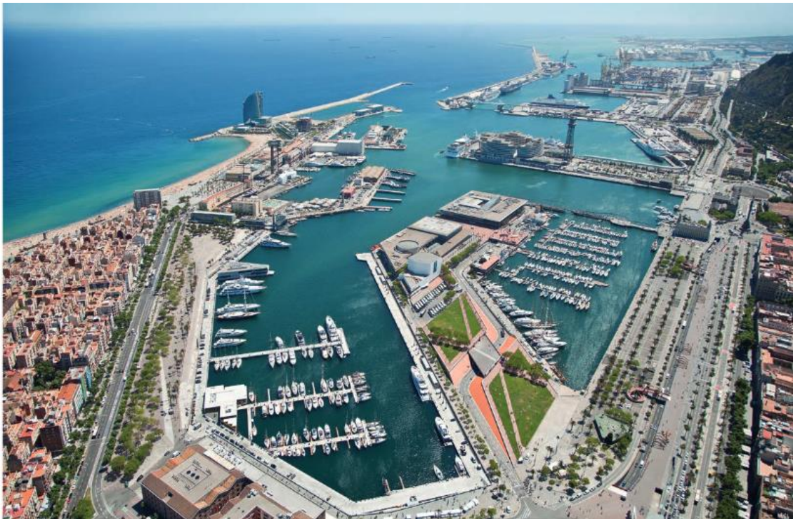
Fig. 03 Vista aèrea del Port Vell. Ramon Vilalta, 2014 en (Alemany, 2020)
