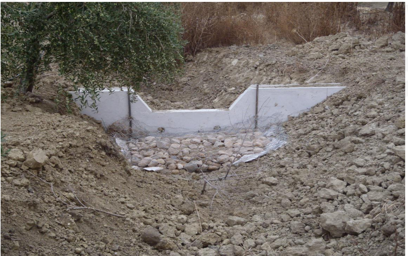
图 3.2.8.4. 小型谷坊溢洪道和坝基防护 (J. A. Gómez 供图)
