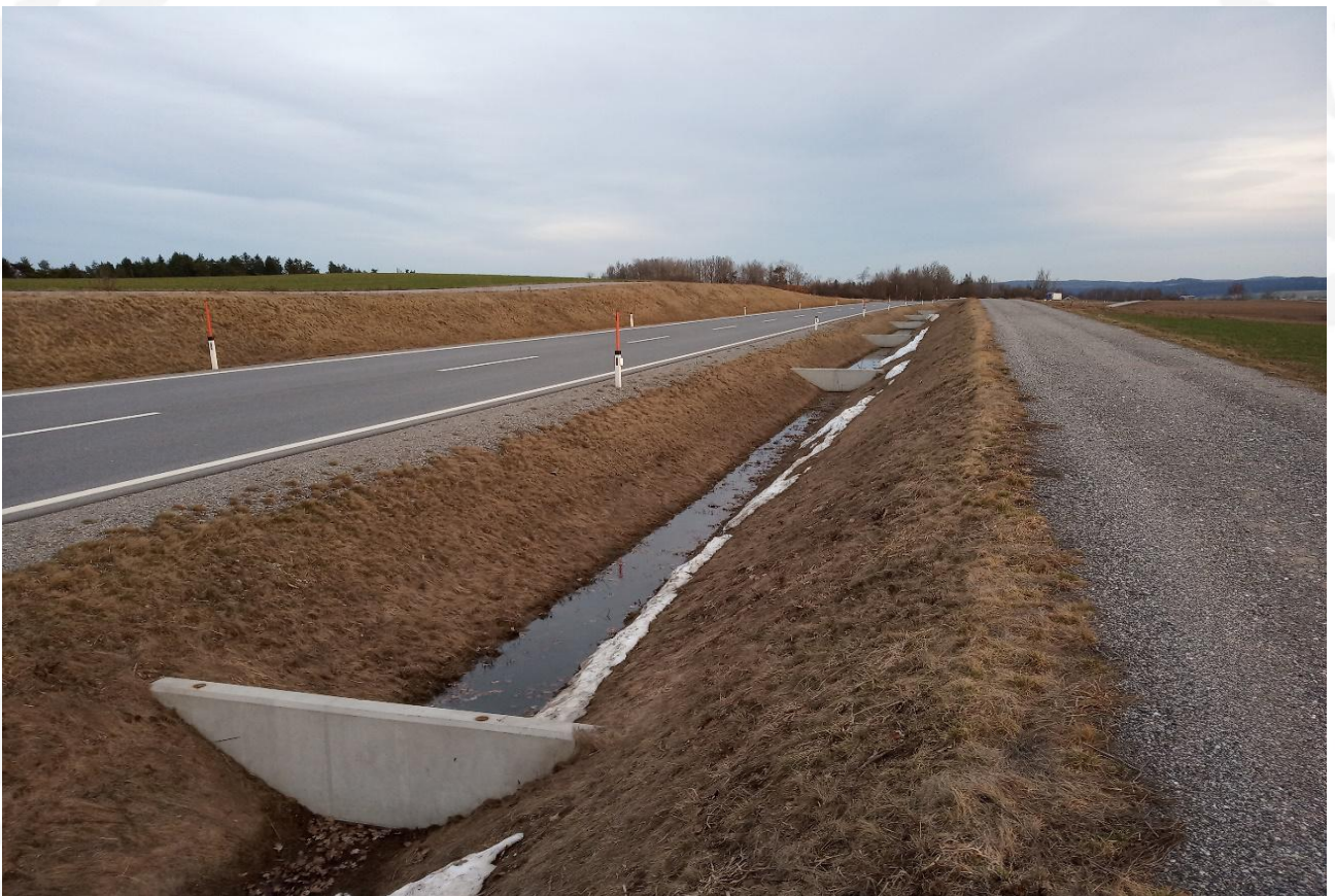
图 3.2.12.9. 路边沟雨水收集（T. Dostal 供图）
