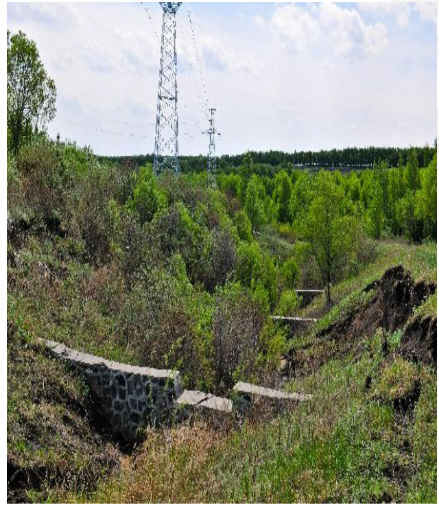
图 3.2.8.5. 中国切沟防治的浆砌石谷坊（孟令钦供图）
