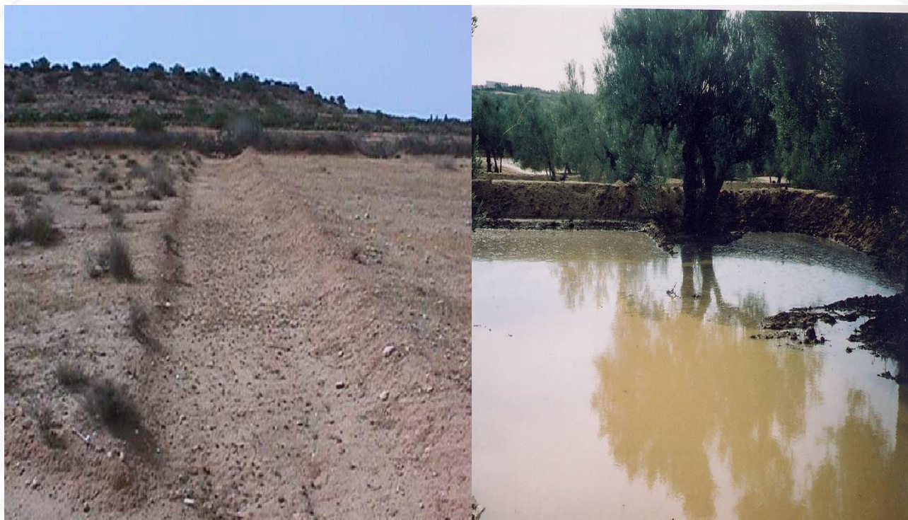
图 3. 2. 12. 7. 突尼斯—橄榄种植区的流域雨水收集 (meskat 系统) 图片; 集水区 (左) 和贮存区 (右) (. Braham 供图)
