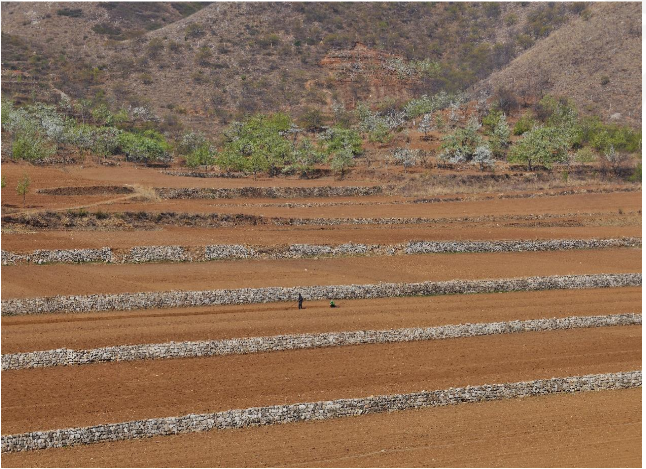
图 3.2.1.8. 石坎水平梯田，位于中国北方山地地区（孟令钦供图）
