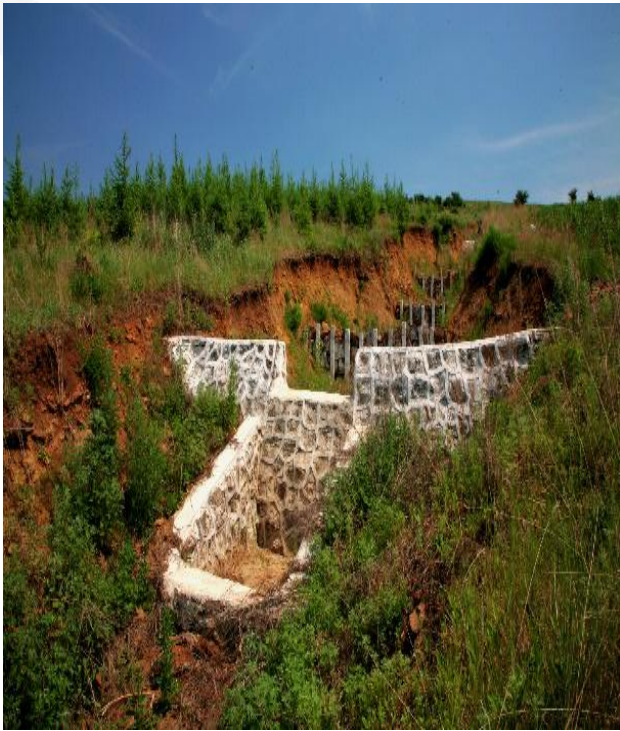
图 3.2.8.5. 中国切沟防治的浆砌石谷坊（孟令钦供图）
