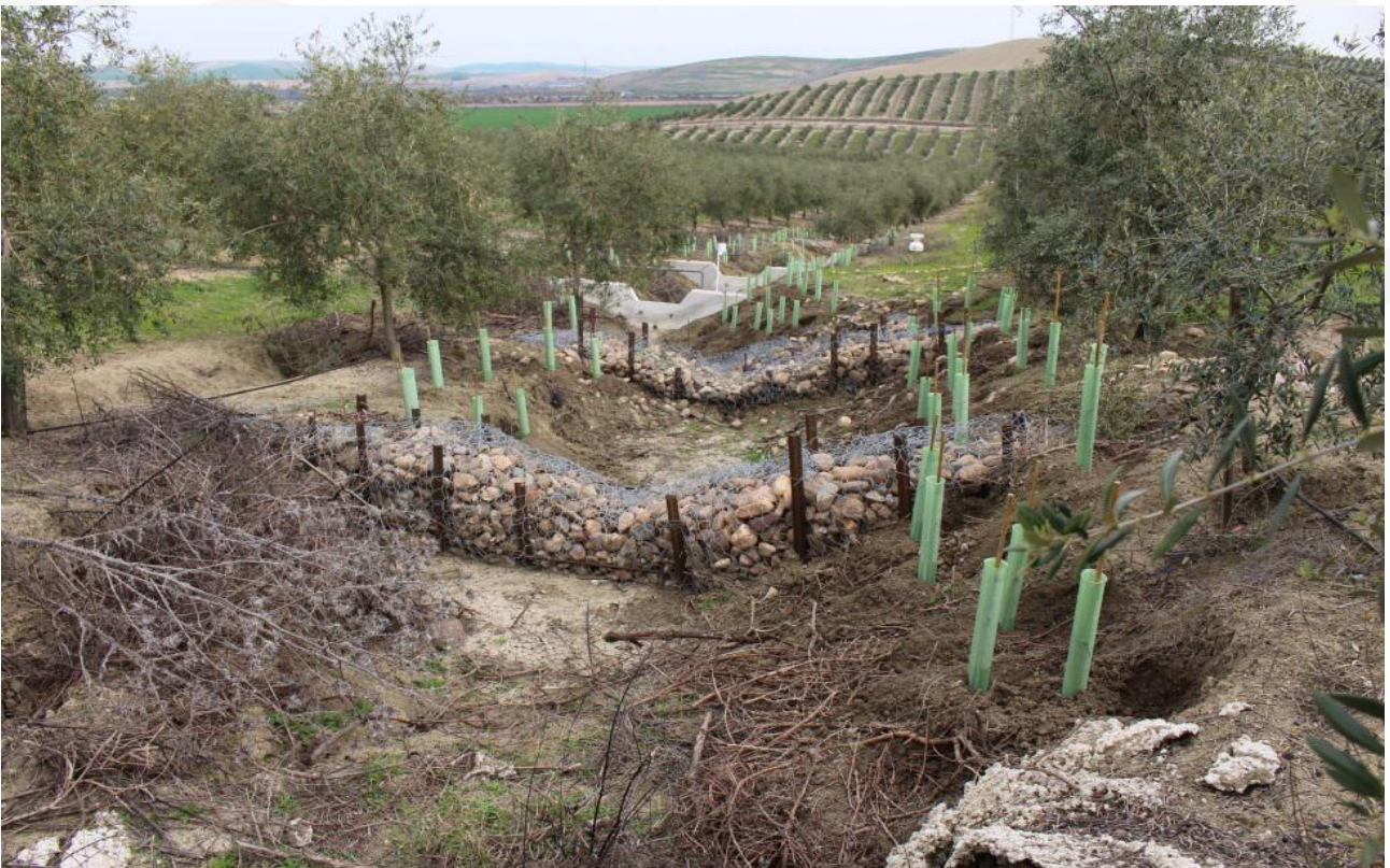
图 3.2.8.2 位于西班牙南部橄榄树果园系列不同设计的谷坊 (J. A. Gómez 供图)
