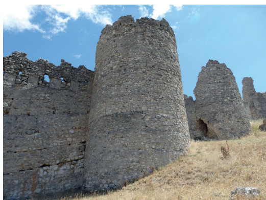
Figura 14. Torres de la muralla de Fuentidueña, Segovia, correspondientes al tramo suroeste. Fuente: Alicia Sainz Esteban. Fecha de captura: 13/08/2014.
