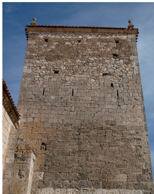
Figura 23. Torre de la iglesia de Rublacedo de Abajo (Burgos), con aspilleras y restos de almenas originales anuladas por el posterior recerido del campanario. Foto del autor, 2015.
