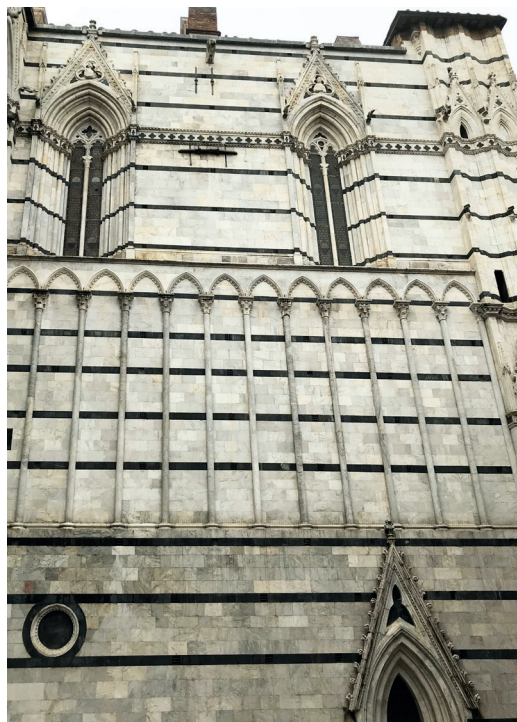
Figura 17. Particolare del fianco sinistro del battistero e del coro con la nuova tipologia di rivestimento marmoreo.
