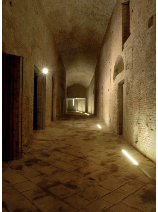
Figura 19. Lungo la cosiddetta 'strada interna' del Santa Maria della Scala sono ancora visibili le facciate delle case del quartiere di Vallepiatta di Sopra, con i portali tamponati, inglobate all'interno dell'ospedale.
