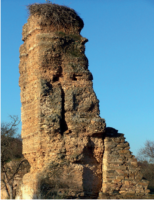
Figura 16. Torre de flanqueo en las murallas de Majādat al-Balāt, mostrando el forro de tapia sobre una torre anterior de piedra
