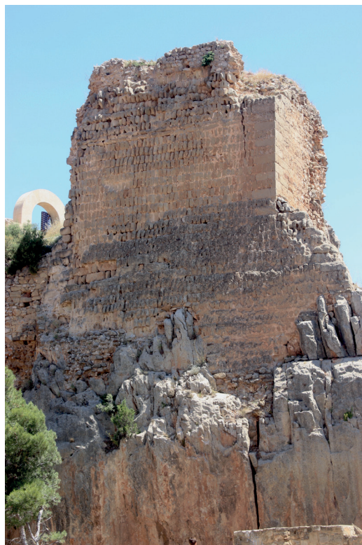
Figura 13. Torre de sillería aparejada a tizón en el castillo de Alpuente
