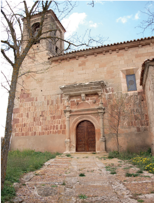
Figura 21. Iglesia de Mezquetillas (Soria), levantada reaprovechando los restos de una fortificación califal previa del siglo X, aun visible en la parte baja de los muros. Fotografía del autor, 2015.
