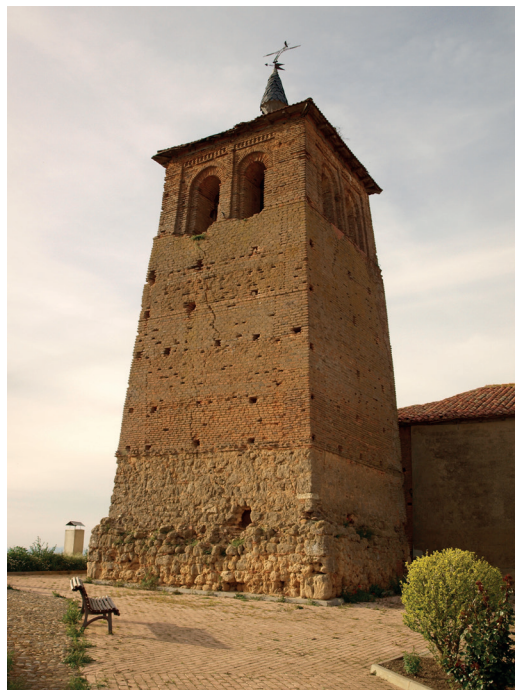
Figura 4. Recio torreón de la iglesia de Villamoratiel de las Matas (León), con desarrollo troncocónico, base de piedra y cuerpo superior de ladrillo. Fotografía del autor, 2015.
