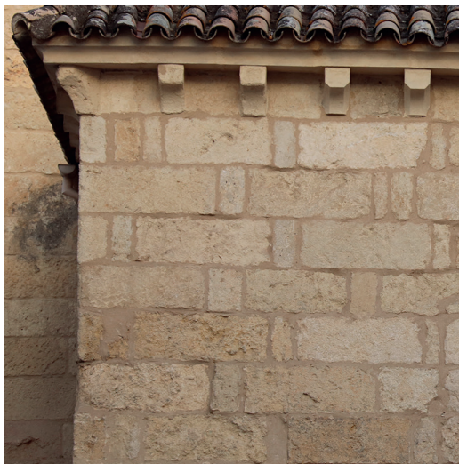
Figura 10. Aparejo a soga y tizón en capilla medieval de San Lorenzo (fotografía del autor)
