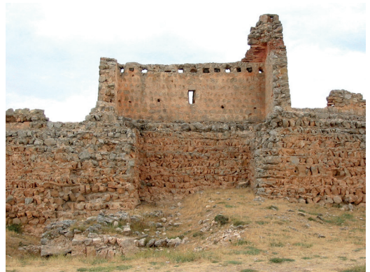
Figura 12. Vista a intramuros de las murallas califales del castillo de Gormaz. Obsérvese la impronta en los muros al adosar contra la desaparecida obra de tapia
