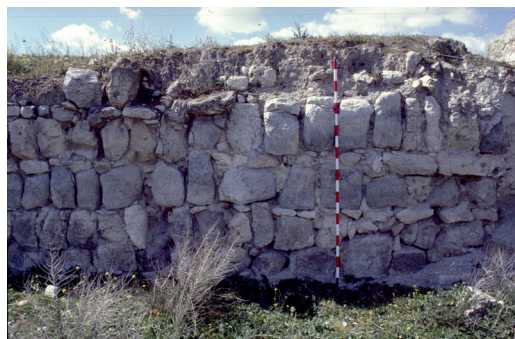
Figura 9. Fábrica de sillarejos atizonados en el frente oriental de la coracha principal de Calatrava la Vieja
