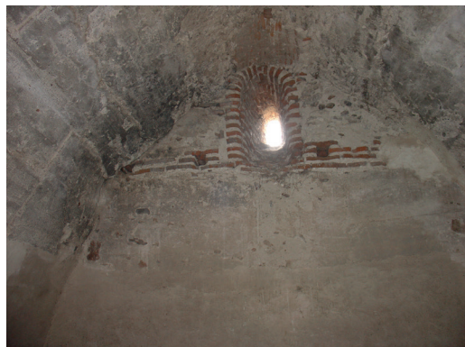
Figura 4. Primera cámara de la torre de Castellanos de Zapardiel, (último tercio del siglo XII), en la que se observa un uso limitado del ladrillo.
