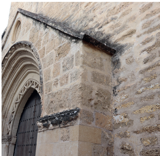
Figura 11. Encuentro entre portada de sillería y muro de mampostería en el hastial de La Magdalena (fotografía del autor)
