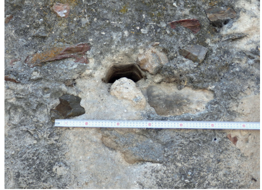
Figura 25. Agujal con forma trapezoidal en la muralla de Coca, Segovia. Fuente: Alicia Sainz Esteban. Fecha de captura: 14/08/2016.
