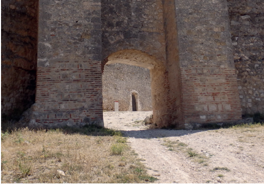
Figura 4. Base de la puerta de Alfonso VIII, en Fuentidueña, construida con mampostería encintada en ladrillo. Fuente: Alicia Sainz Esteban. Fecha de captura: 10/12/2014.
