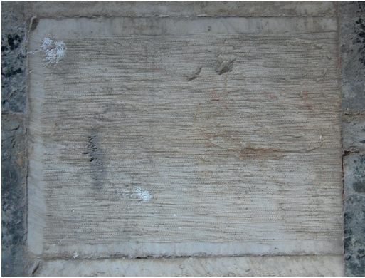
Figura 28. Particolare di un elemento del rivestimento marmoreo di seconda metà Duecento. Il 'nastrino' perimetrale che delimita le quattro facce del blocco è conservato solo su tre lati perché il concio, lavorato con misure standard già in cava, è stato ridotto di lunghezza al momento della posa in opera.
