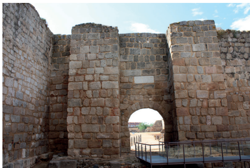
Figura 6. Puerta interior del complejo de acceso a la alcazaba de Mérida
