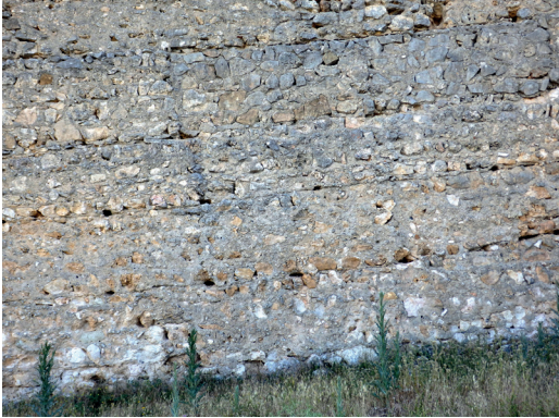
Figura 24. Tapia realizada con tapial corrido en Fuentidueña, Segovia. Fuente: Alicia Sainz Esteban. Fecha de captura: 17/06/2014.
