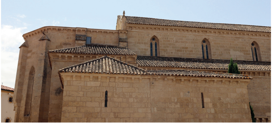
Figura 3. Cabecera y cuerpo de naves de San Lorenzo (fotografía del autor)
