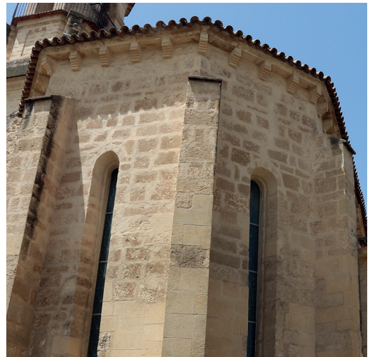
Figura 12. Fábrica de sillería en el ábside central de La Magdalena (fotografía del autor)
