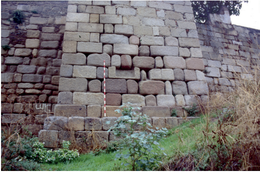
Figura 2. Sillería de acarreo en las murallas de Coria
