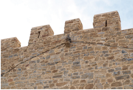
Figura 28. Iglesia fortificada de Nª Sª del Collado de Valtajeros (Soria), detalle de receruido defensivo sobre la primitiva línea de cubiertas. Foto del autor, 2017.
