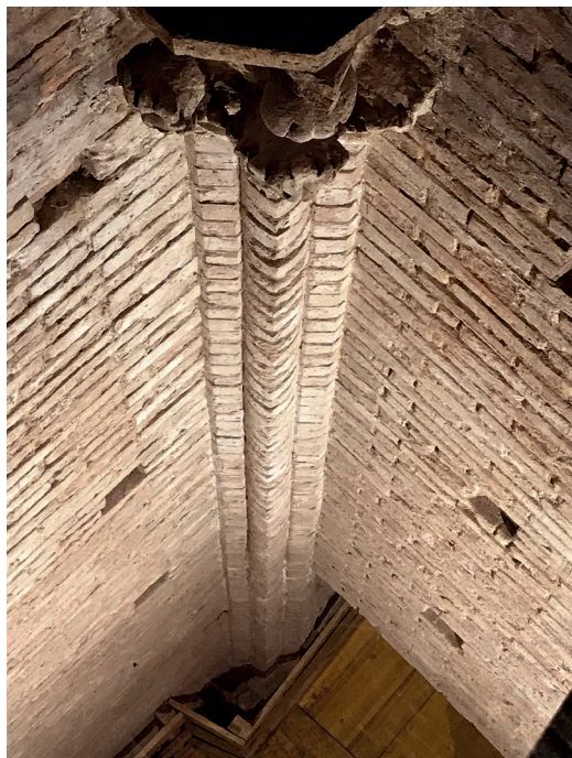
Figura 20. Uno dei semipilastri composti della grande sala, rimasta incompiuta, situata sotto al braccio sinistro del transetto trecentesco del duomo.
