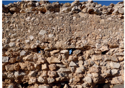
Figura 27. Agujales cuyas agujas han desaparecido en la construcción de aspecto defensivo que domina la localidad de Montejo de la Serrezuela, Segovia. Fuente: Alicia Sainz Esteban. Fecha de captura: 10/12/2014.
