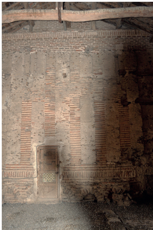
Figura 3. Fachada este de la torre de Santa María del Castillo con su particular decoración de arquillos en el cuerpo inferior y de bandas alternadas de ladrillo y calicanto en el cuerpo superior.
