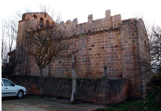
Figura 17. Adarve defensivo sobre los muros de la nave de la iglesia románica de Fuensaúco (Soria). Foto del autor 2015.
