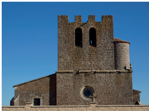
Figura 11. Azotea almenada de la torre de la iglesia de Ventosa de Pisuerga (Palencia).
