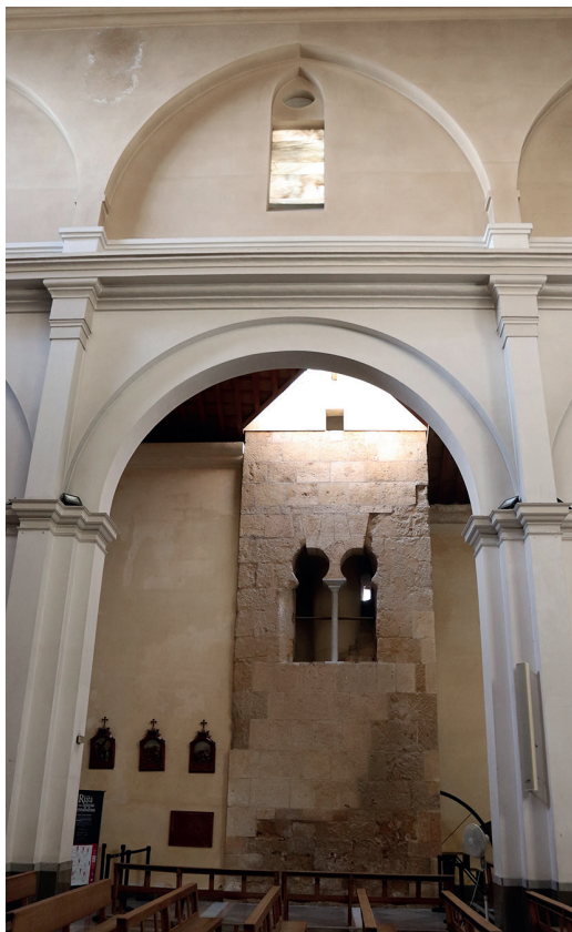
Figura 8. Alminar integrado en el muro del evangelio de Santiago (fotografía del autor)
