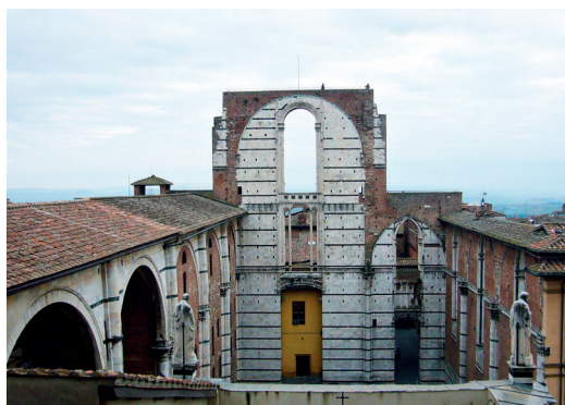
Figura 24. Veduta panoramica delle strutture del Duomo Nuovo.
