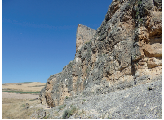
Figura 7. Remate de la muralla de Fuentidueña, construida sobre la roca, en el extremo sur del recinto. Fuente: Alicia Sainz Esteban. Fecha de captura: 8/7/2015.
