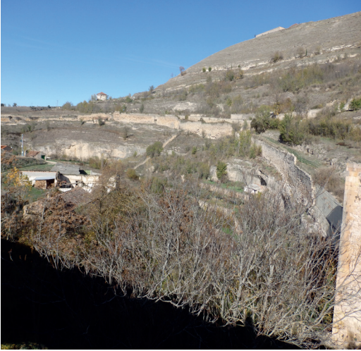
Figura 17. Tramo de muralla que va formando un arco al adaptarse al terreno. No se ven torres de flanqueo en 400,00 m. Sepúlveda, Segovia. Fuente: Alicia Sainz Esteban. Fecha de captura: 11/11/2015.
