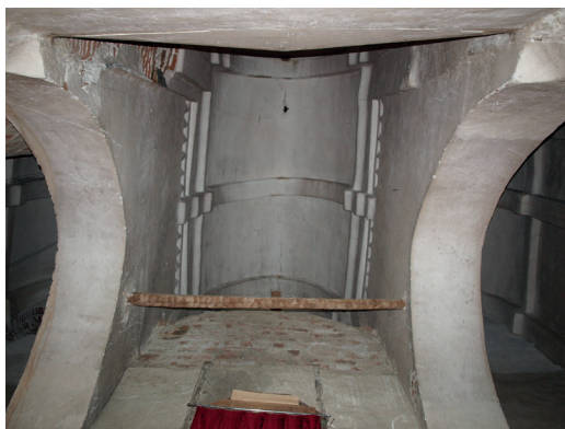
Figura 12. Interior de la primitiva cabecera de la iglesia de Barromán, sobre la que se yergue la torre defensiva. Foto del autor 2015.
