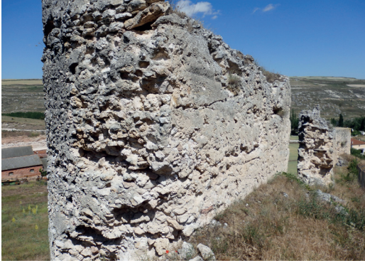
Figura 15. Parte interior de la torre de flanqueo semicircular en Fuentidueña. La muralla en este tramo ha desaparecido, dejando al descubierto la parte de la torre que estaba adosada al muro. En el fondo, se ve el reducido espesor de la muralla. Fuente: Alicia Sainz Esteban. Fecha de captura: 17/06/2014.
