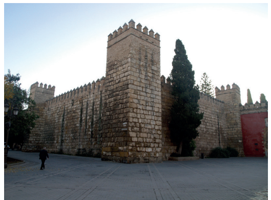
Figura 14. Fábricas de sillería de acarreo en el alcázar de Sevilla
