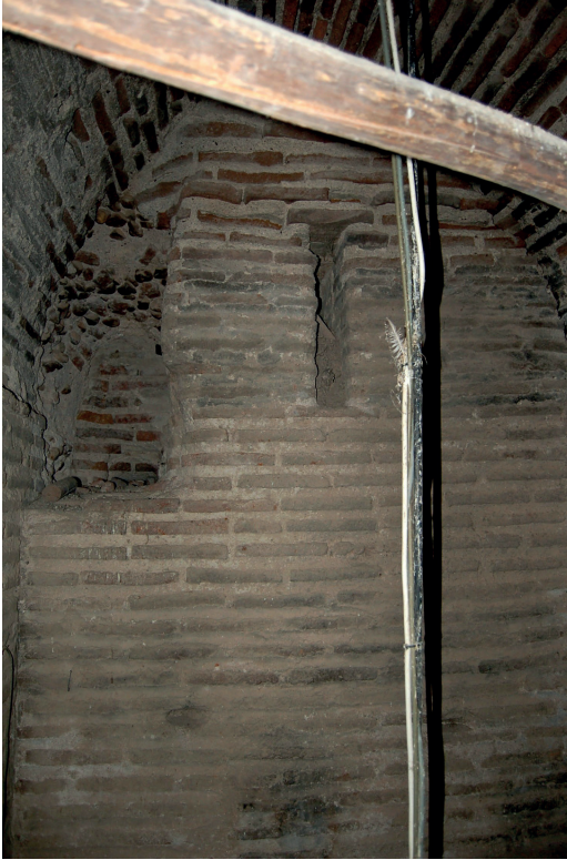
Figura 5. Segunda cámara medieval de la torre de San Nicolás en Madrigal (posterior al primer tercio del siglo XIII), donde se aprecia el empleo más profuso del ladrillo.
