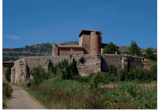
Figura 16. Iglesia de San Andrés de Soto de Bureba (consagrada en 1176), con potente muralla situada solo en una parte de la iglesia, con fines de contención del terreno, delimitación del espacio sagrada y misión disuasoria frente a un ataque. Foto del autor 2016.
