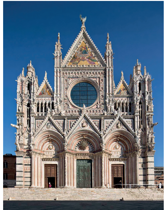
Figura 16. La facciata occidentale del duomo. (Opera della Metropolitana di Siena)
