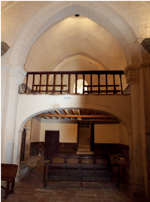
Figura 24. Interior del ábside románico de la iglesia de Hinojosa del Campo (Soria) sobre el que se levanta la torre defensiva. Tras la construcción de una nueva cabecera en el otro extremo del templo el antiguo ábside pasó a cumplir las funciones de coro. Foto del autor, 2017.
