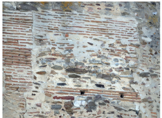
Figura 28. Elementos de ladrillo en la muralla de Coca. Fuente: Alicia Sainz Esteban. Fecha de captura: 14/08/2016.
