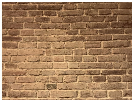
Figura 22. Muratura in laterizi del duomo.
