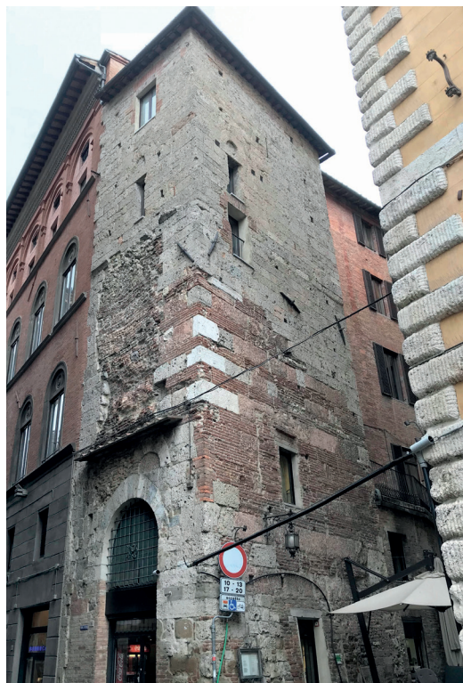
Figura 12. La torre in via Montanini, con il materiale romano di reimpiego squadrato e spianato a imitazione del paramento murario dell'edificio in cui è inserito.
