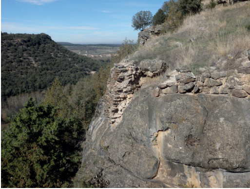
Figura 6. Arranque de muros sobre la roca en zonas con gran desnivel. Pedraza de la Sierra (Segovia). Fuente: Alicia Sainz Esteban. Fecha de captura: 18/11/2015.
