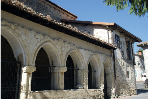
Figura 14. Pórtico de la fase 2 de la parroquia de San Pedro (Monasterioguren).
