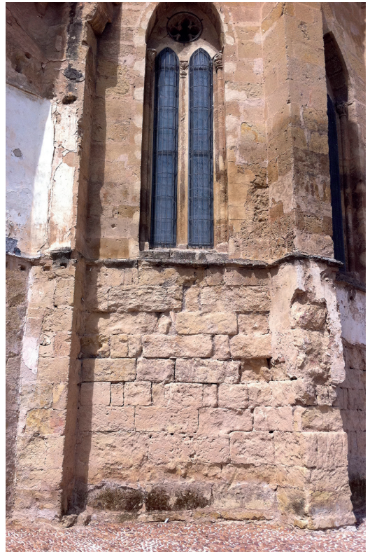
Figura 13. Aparejo a soga y tizón en la cabecera de Santa Marina (fotografía del autor)
