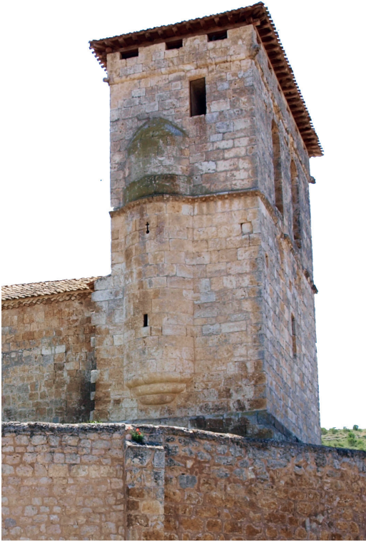
Figura 2. Husillo con tronera en la iglesia de Pinillos de Es-gueva (Burgos). Fotografía del autor, 2015.
