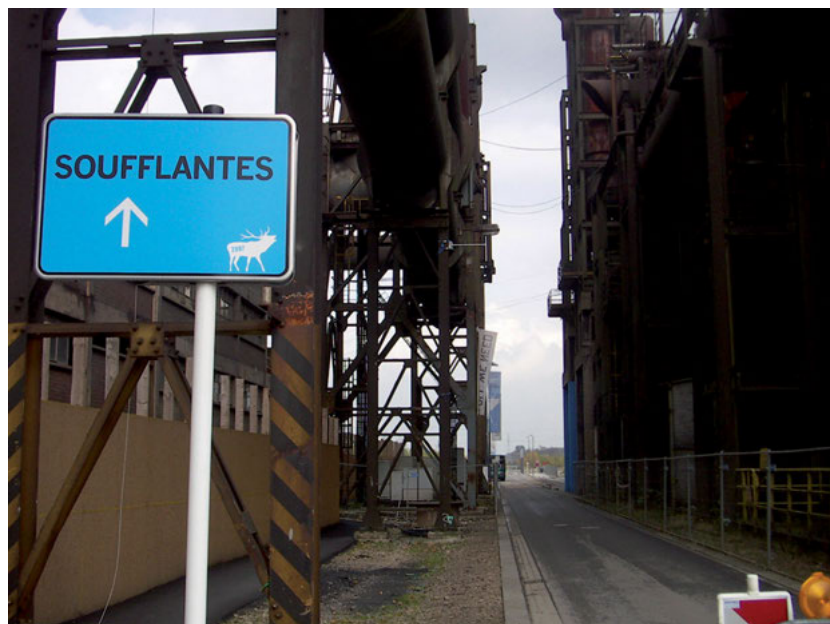
Illustration 1 : Le site des Soufflantes, Esch-Belval, 2007 (Photo : G. Crenn)
