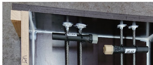
Figur 3.3 Gjutform samt två trådlösa fuktsensorer av Electrotech monterade på armeringsjärn på olika höjd
