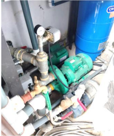
Figura 15. Mantenimiento de instalaciones de agua
