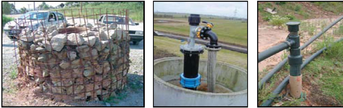
Figura 3: Drenos, modelo vertical e horizontal para extração do biogás
