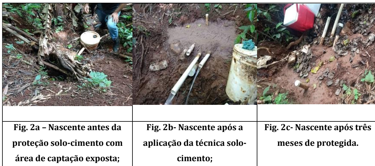
Figura 2: Proteção da segunda nascente no município de Luiziana-PR Fonte: Os Autores, 2021.
