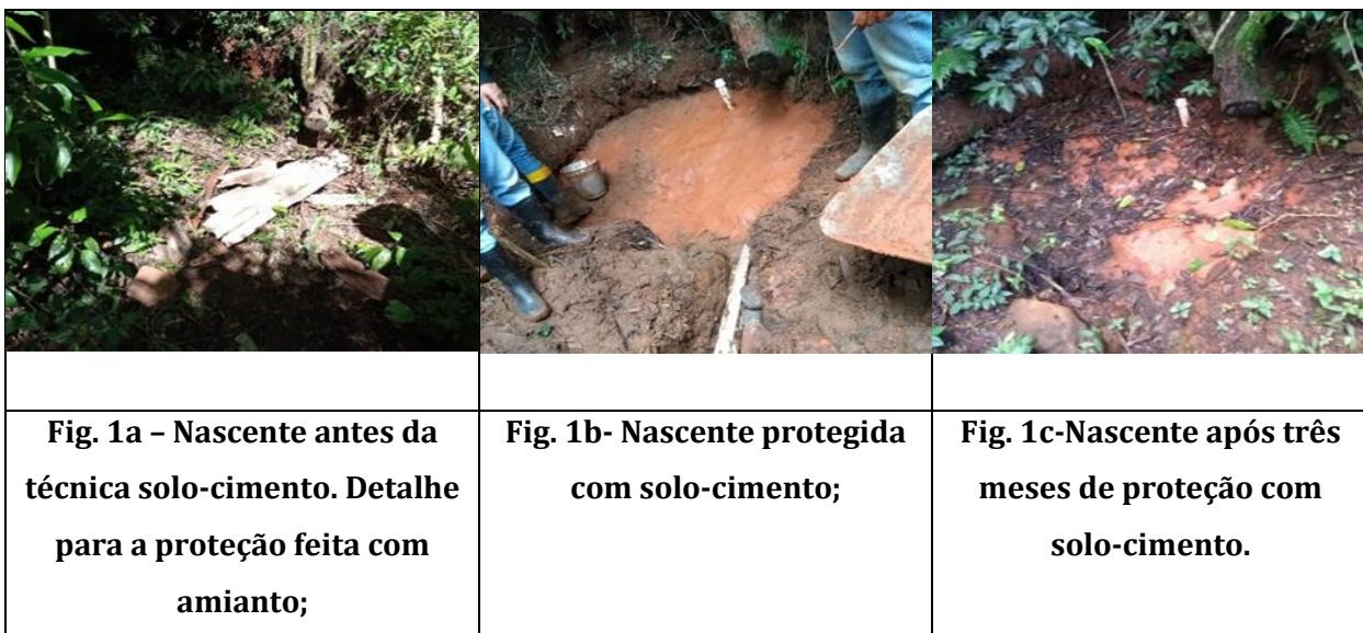
Figura 1: Proteção da primeira nascente no município de Luiziana-PR. Fonte: Os Autores, 2021.
