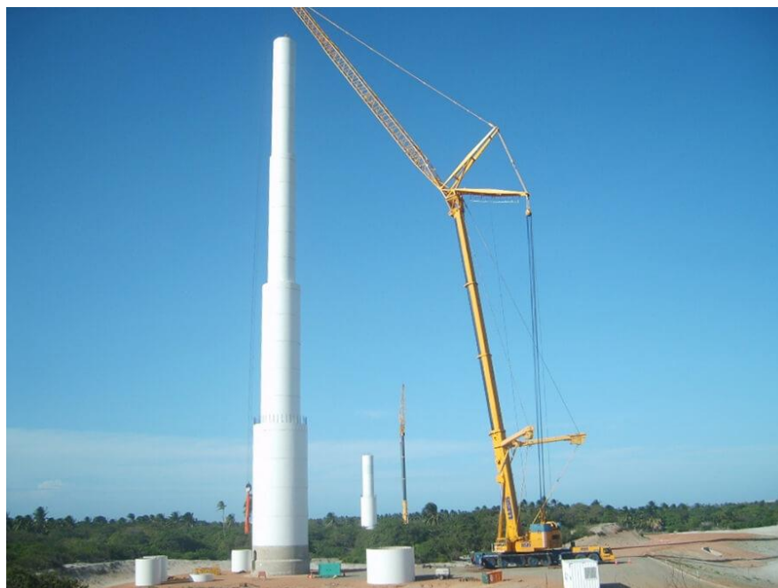
Figura 8 – Montagem de Torre de Aerogerador em Concreto Pré-moldado
