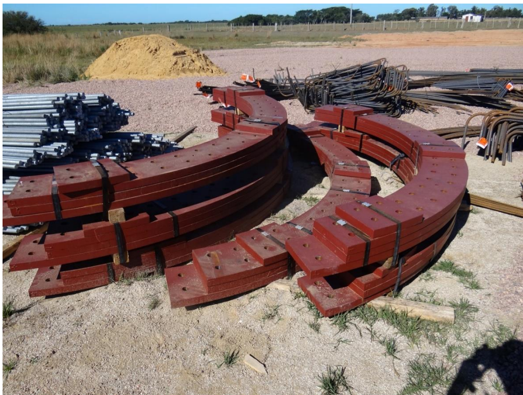
Foto 7 – Materiais Utilizados na Construção do Flange
