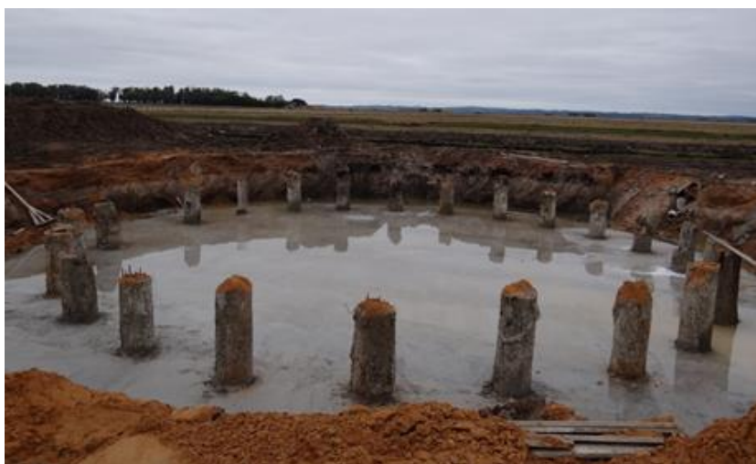
Foto 19 – Lastro de Concreto Magro e 22 Estacas Dispostas Circularmente
