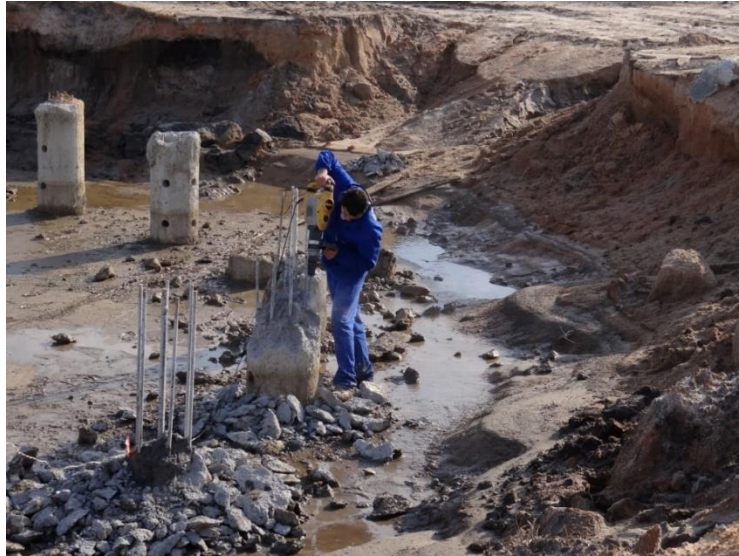
Foto 21 – Arrasamento das Estacas
