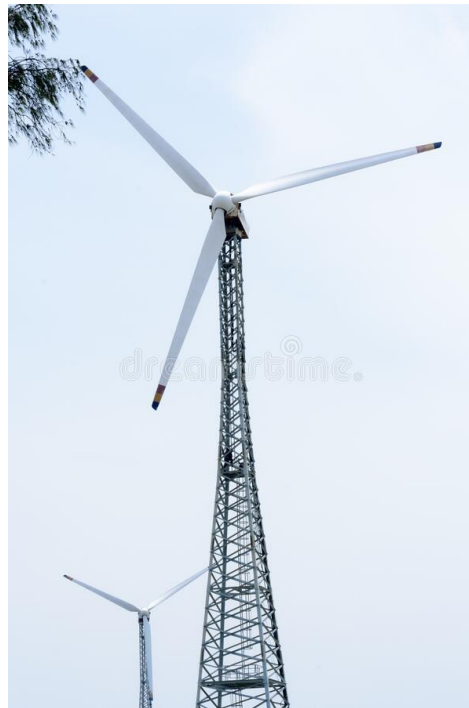
Figura 6 – Torre de Aerogerador em Estrutura Treliçada
