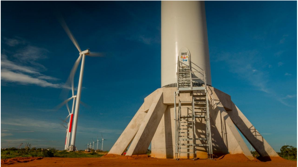
Foto 3 – Solução de Fundação Direta Elevada
