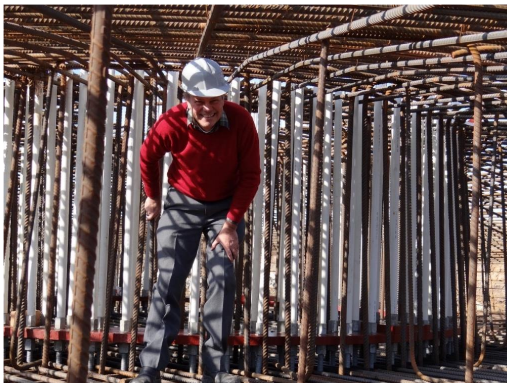
Foto 14 – Bloco de Coroamento por “dentro”
