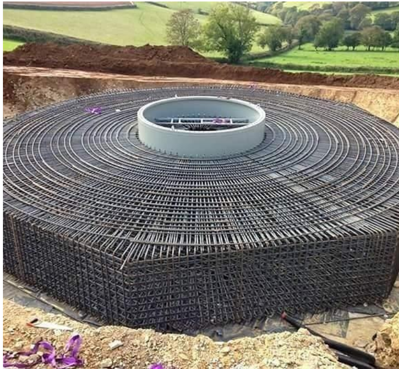
Figura 17 – Fundação Superficial do Tipo Sapata para Aerogerador
