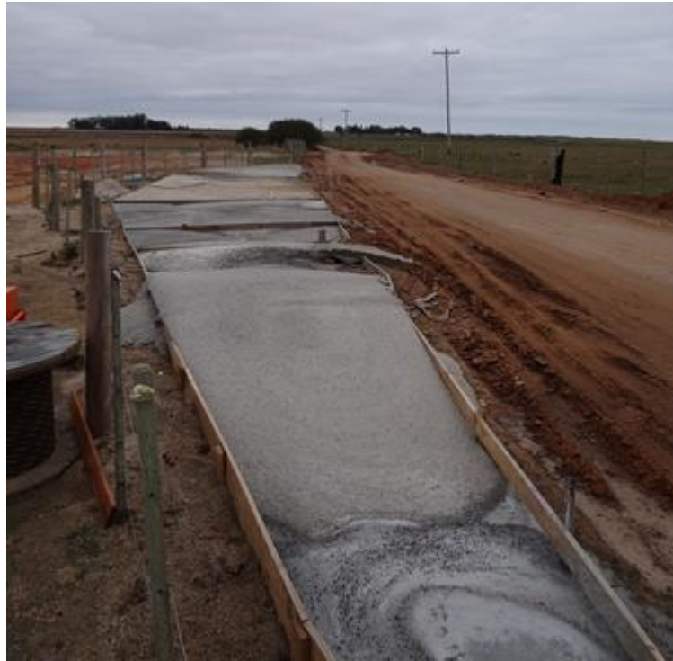
Foto 16 – Descarga do Fundo dos Caminhões Betoneira - Lavagem
