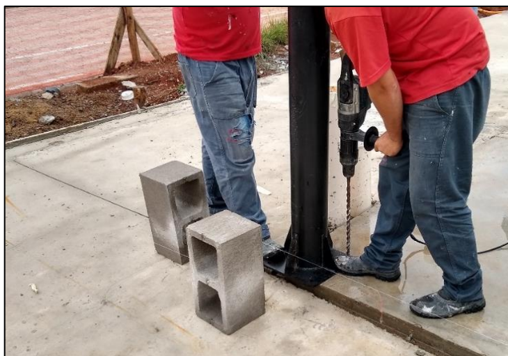
Figura 32 – Perfuração da laje para chumbar pilares metálicos
