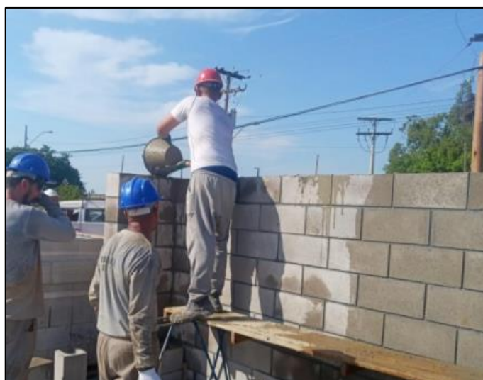
Figura 30 - Lançamento de graute com balde
