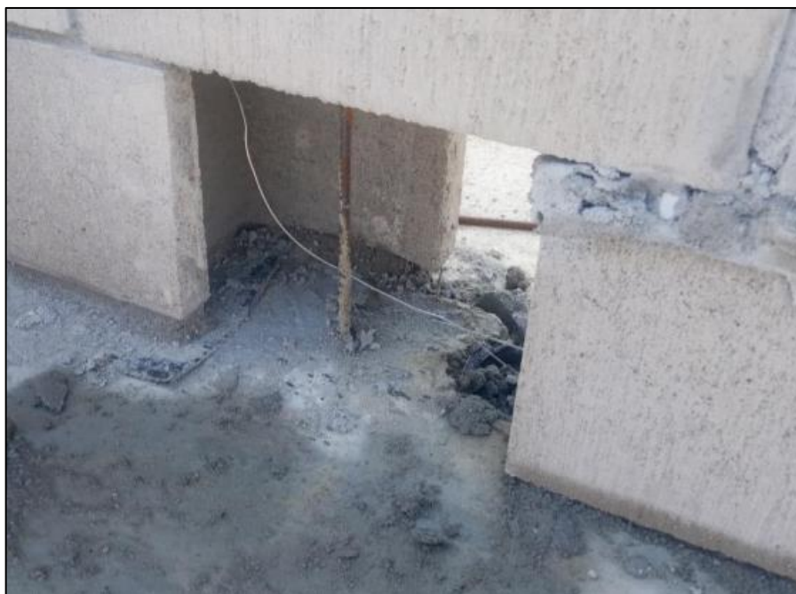
Figura 27 - Janela de inspeção na alvenaria
