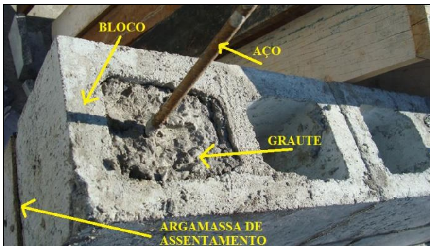
Figura 3 - Elementos que compõem alvenaria estrutural
