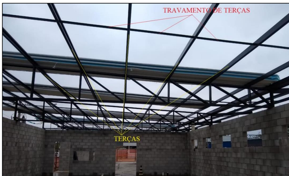
Figura 42 - Terças e travamentos
