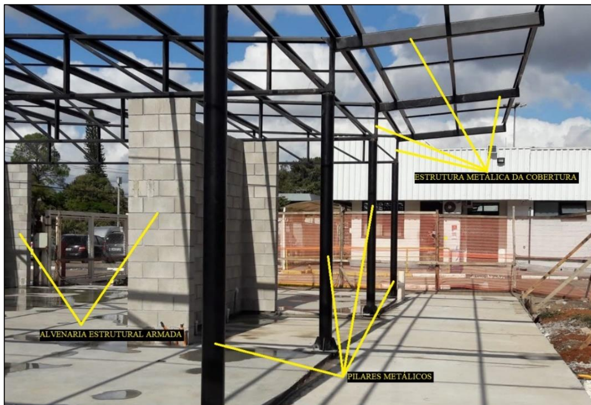
Figura 13 - Foto da construção da fachada oeste da edificação
