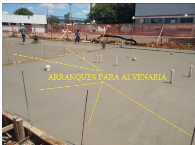
Figura 18 - Laje sendo concretada com os arranques da alvenaria posicionados
