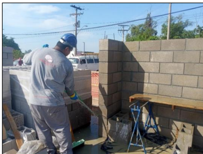
Figura 29 - Limpeza dos furos antes do grauteamento
