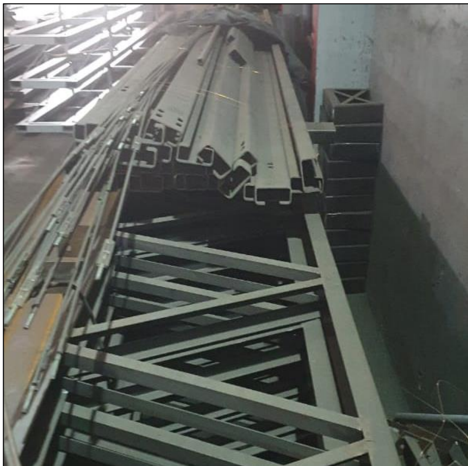
Figura 15 - Elementos metálicos antes da pintura
