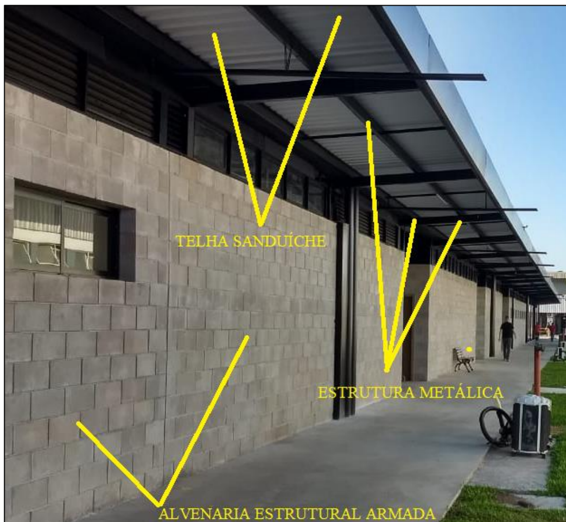
Figura 12 - Foto da fachada oeste da edificação
