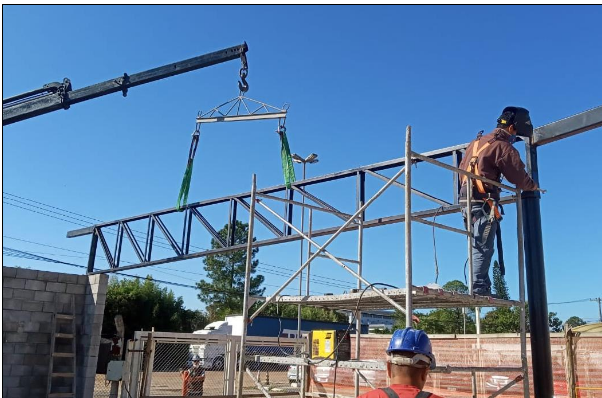
Figura 40 - Elevação do módulo da tesoura treliçada e soldagem
