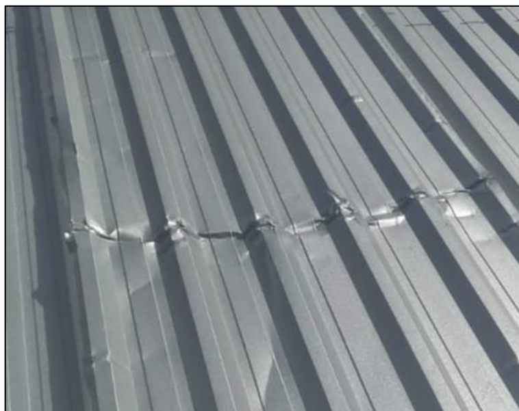
Figura 47 - Telha amassada
