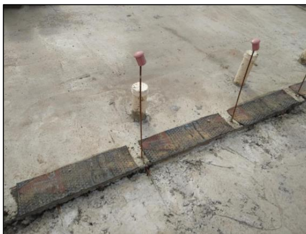
Figura 23 - Impermeabilização com manta asfáltica
