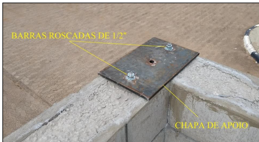
Figura 33 - Chapa de apoio de tesouras treliçadas fixada na alvenaria
