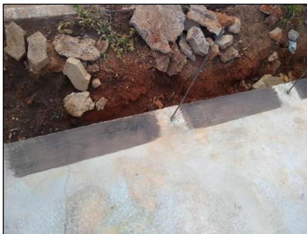
Figura 22 - Impermeabilização com emulsão asfáltica
