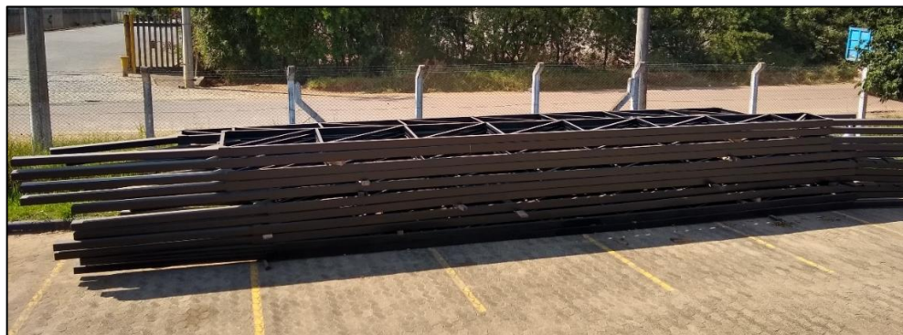
Figura 37 - Módulo das tesouras treliçadas na obra
