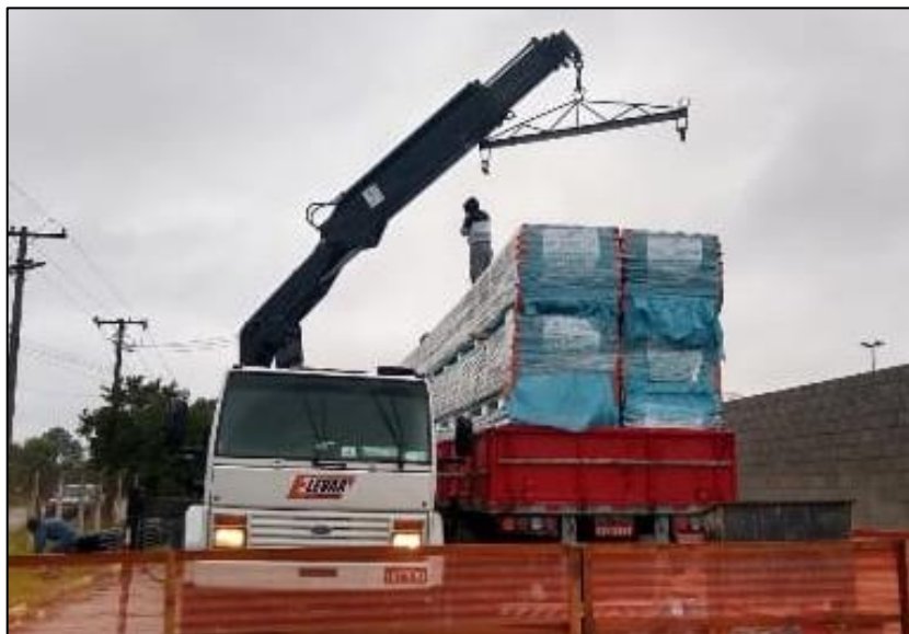
Figura 48 - Processo de descarga de materiais na obra
