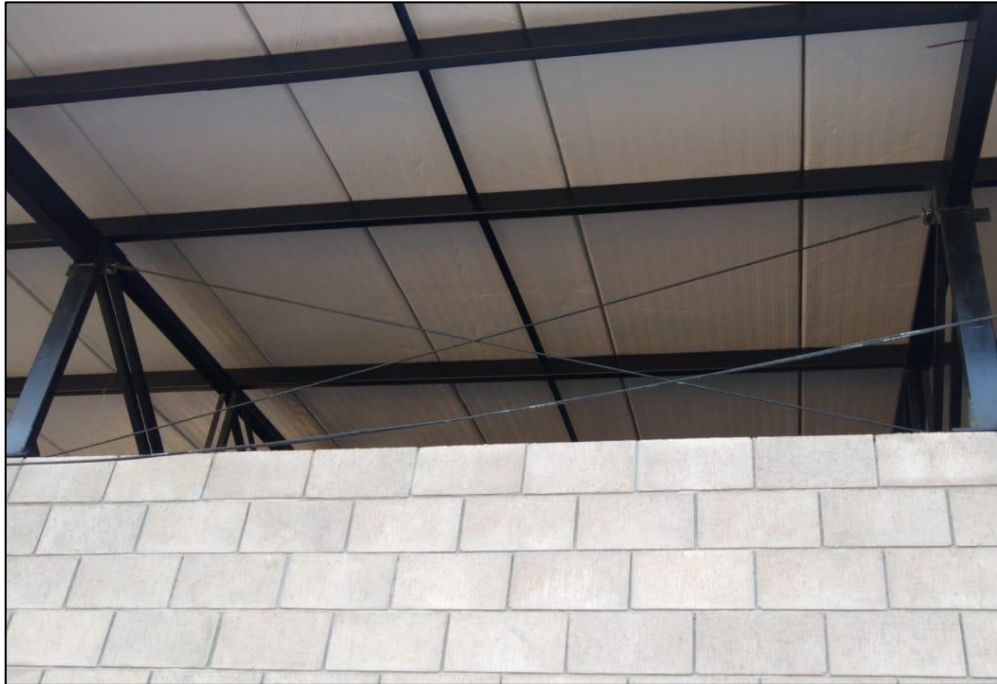
Figura 44 - contraventamentos das tesouras treliçadas
