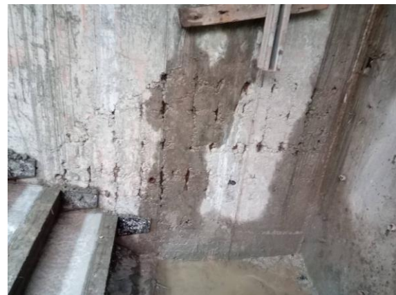
Figura 2 - Exemplos de falhas nos procedimentos de concretagem evidenciando (a) a falta de concreto e (b) a exposição de armadura
