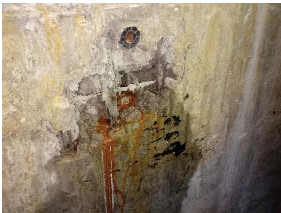
Figura 2 - Exemplos de falhas nos procedimentos de concretagem evidenciando (a) a falta de concreto e (b) a exposição de armadura
