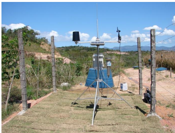
Figura 1. Estação meteorológica instalada no topo do talude de corte em abrigo meteorológico com o pluviômetro Ville de Paris ao fundo.
