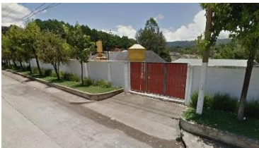
Colindancia Noroeste Bodega de empresa productora de materiales de construcción
