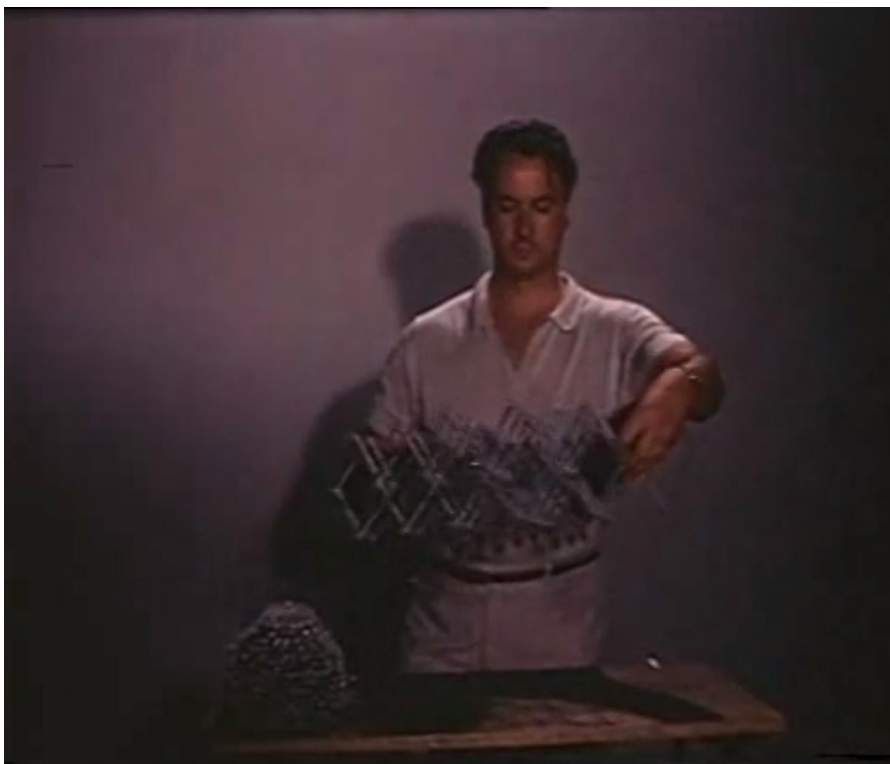
Imagen 120: Funcionamiento del modelo plano accionado por el propio Pérez Piñero, recogido en el domunetal "Las estructuras vivas de Pérez Piñero". Ver a partir del minuto 2 el modelo inicial esférico (UIA)
