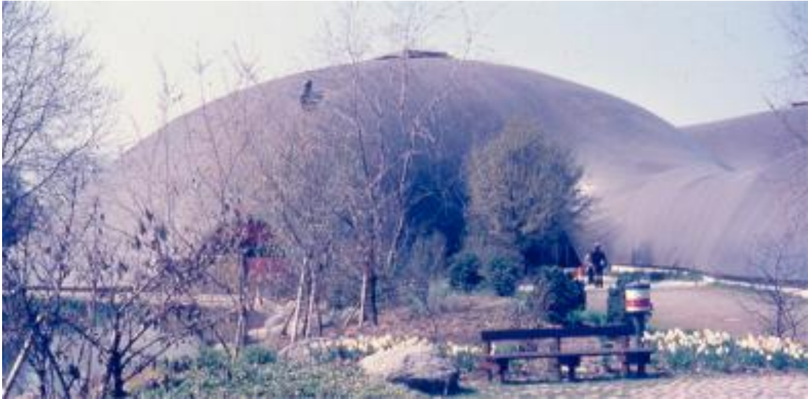
Imagen 176: La celosía cubierta con tela de celosía recubierta de PVC oscura pero translúcida.
