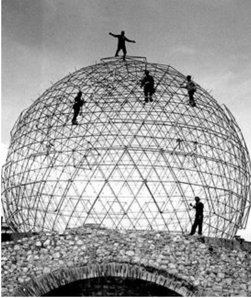
138c: Durante la construcción de la cúpula para el Museo de Figueras.
