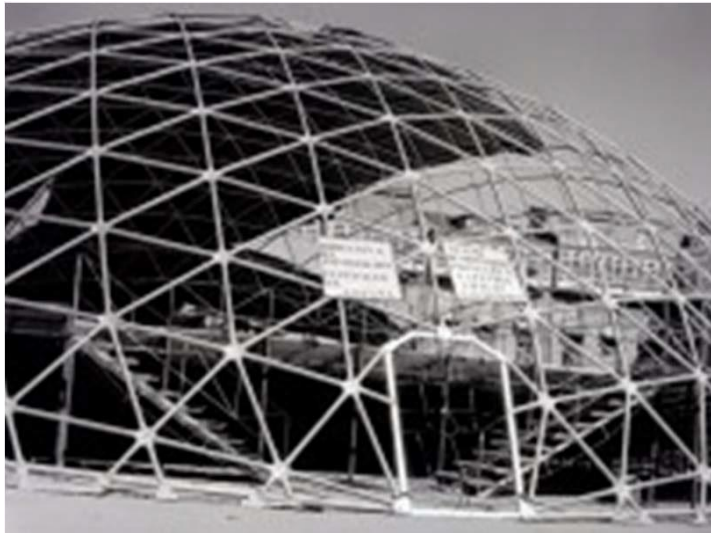
Imagen 136: Estructura durante las pruebas en Calasparra y una vez montada en A Coruña.
