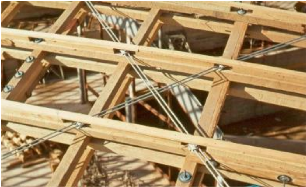
Imagen 171: Detalle de la construcción de la red.
