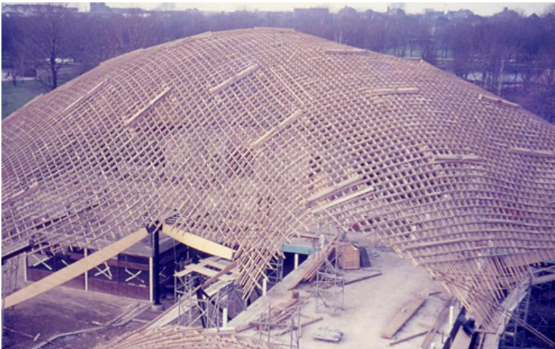
Imagen 175: Disposición de la celosía en su elevación.
