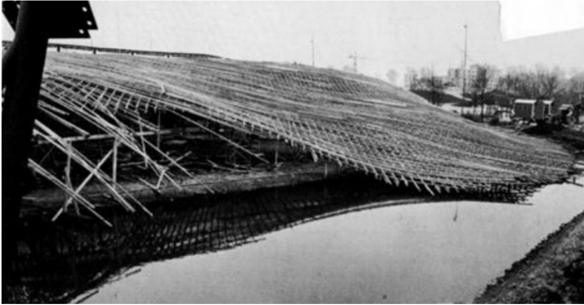
Imagen 159: Celosía completa antes de ser instalada
