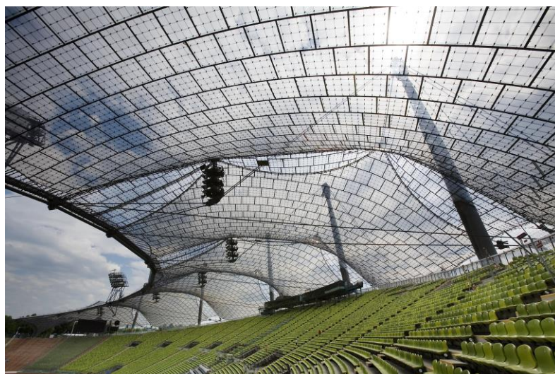
Imagen 152: Grandes obras de Frei Otto: Estadio Olímpico de Múnich. Todas ellas funcionando a tracción. El Multihalle permite dar un nuevo rumbo a la investigación de Frei Otto.
