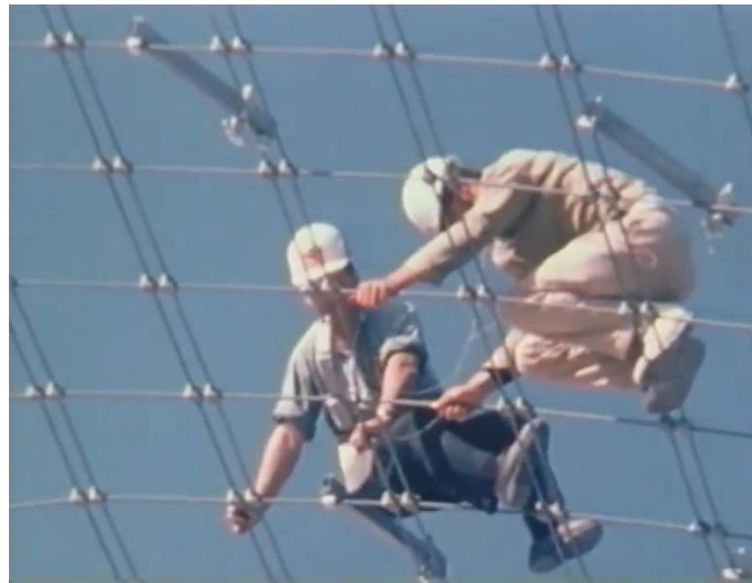
Imágenes 74: Operarios trabajando en la construcción del Pabellón. Una construcción atípica.
