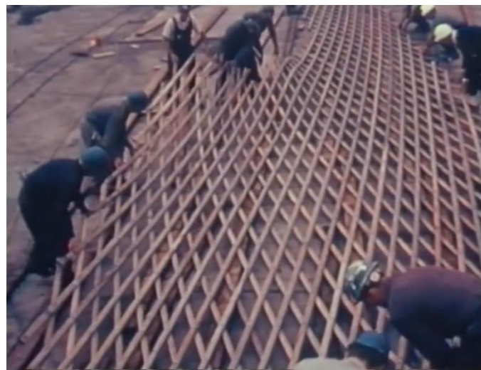
Imagen 75: Plegado de la celosía de madera
