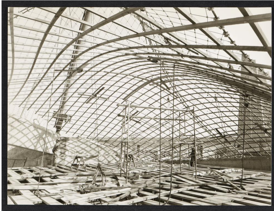
Imagen 76: Cúpula celosía del interior del Pabellón.
