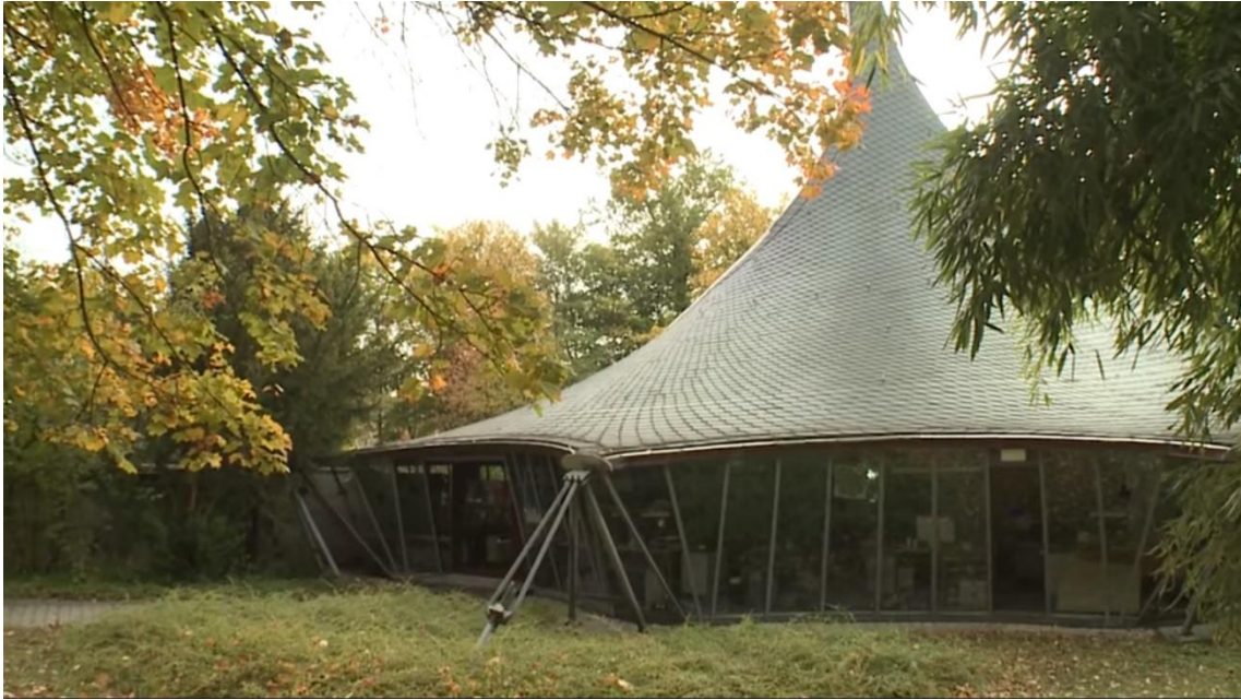
Imagen 80: Exterior del Estructuras Ligeras de la Universidad de Stuttgart, que sirvió como modelo 1:1 de comprobación para la elaboración del Pabellón Alemán de la Expo'67
