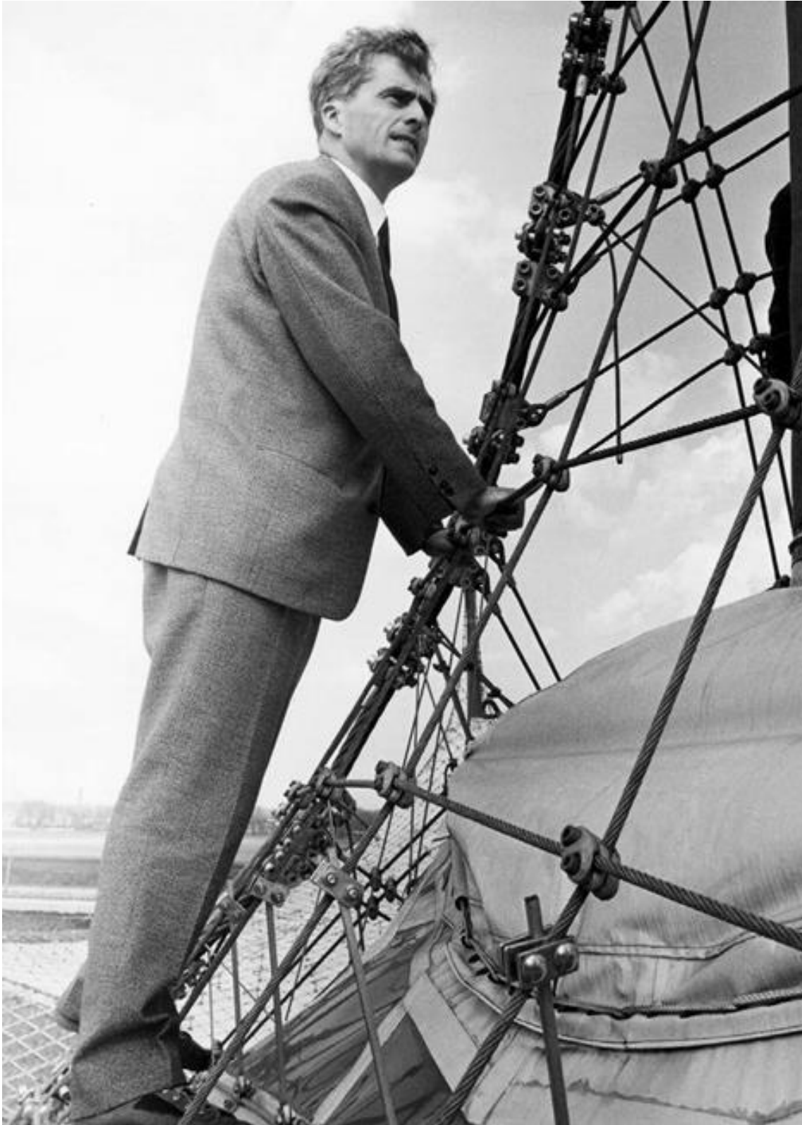
Imagen 99b: Frei Otto subido a la estructura de cables que sirvió de modelo físico estructural de pruebas para el pabellón alemán en 1967.
