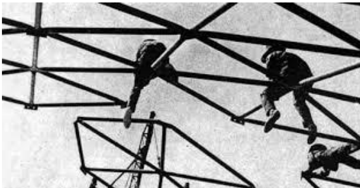
Imagen 134: Montaje por piezas de conjuntos de barras, principal aportación de Emilio Pérez Piñero a la construcción de cúpulas geodésicas.
