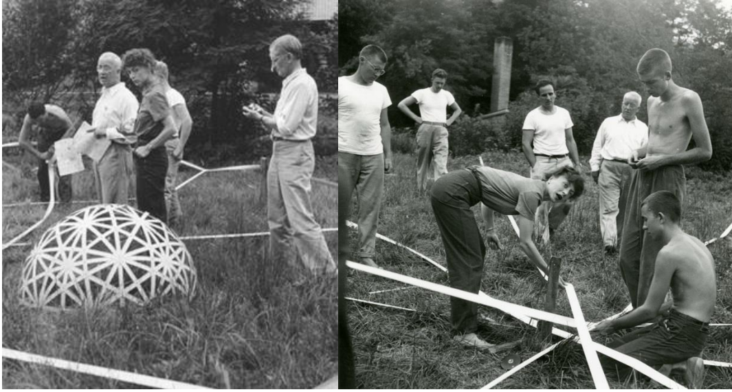
Imagen 47. Primer experimento (fallido) de cúpula con láminas de vinilo de colores. Verano de 1948, Black Mountain College.
