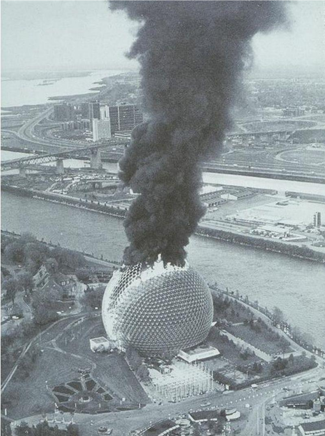
Imagen 40. Incendio en 1976. La membrana plástica arde en escasos minutos.
