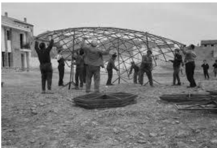
Imagen 135: Estructura durante las pruebas en Calasparra y una vez montada en A Coruña.
