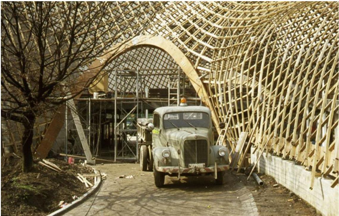
Imagen 162: Imágenes de la construcción Archivo del IL (Instituto de Estructuras Ligeras de la Universidad de Stuttgart)
