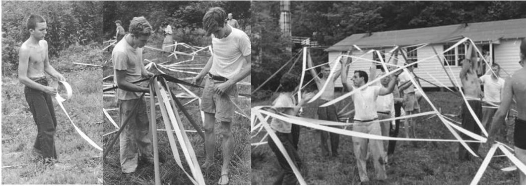
Imagen 47. Primer experimento (fallido) de cúpula con láminas de vinilo de colores. Verano de 1948, Black Mountain College.
