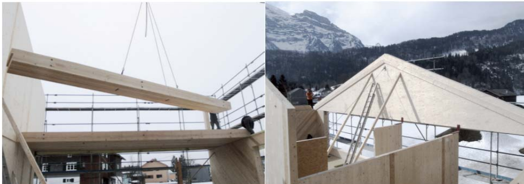
Fotografía 37 y 38. Fase de construcción guardería en Bizau.
