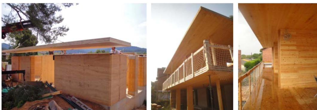
Fotografía 15, 16 y 17. Fase de obra de la Casa Guiu
