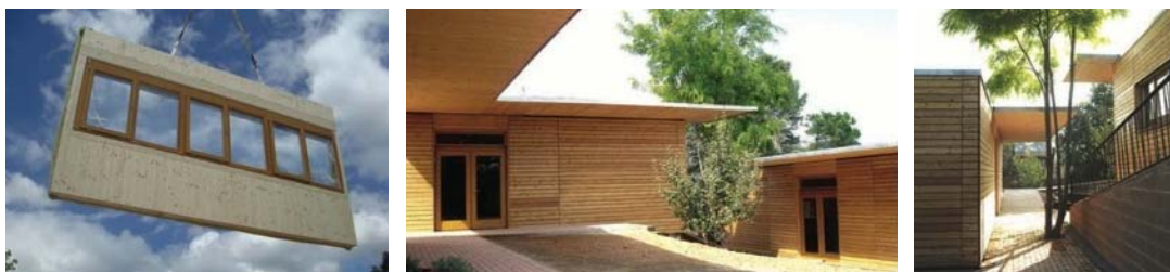
Fotografía 12, 13 y 14. Fase de obra y acabados de la Escuela Waldorf-Steiner
