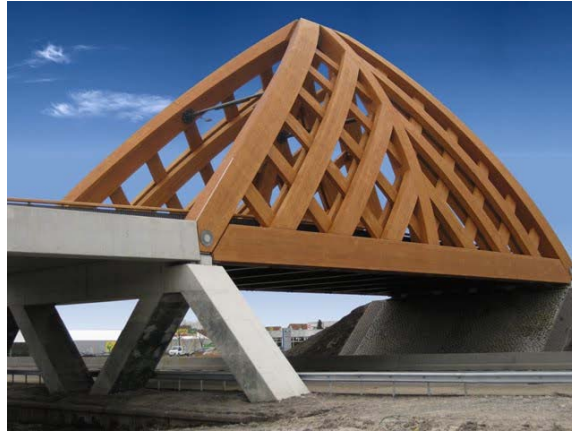
Fotografía 21. Puente de Sneek, Holanda. Primer puente de madera en aguantar 60 toneladas. Tiene una vida útil de 80 años.
