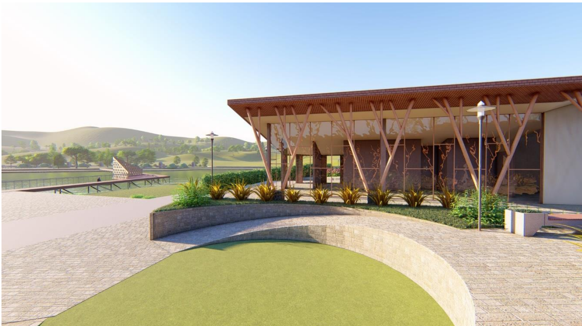
Figura 4.27. Vista exterior - ingreso.
