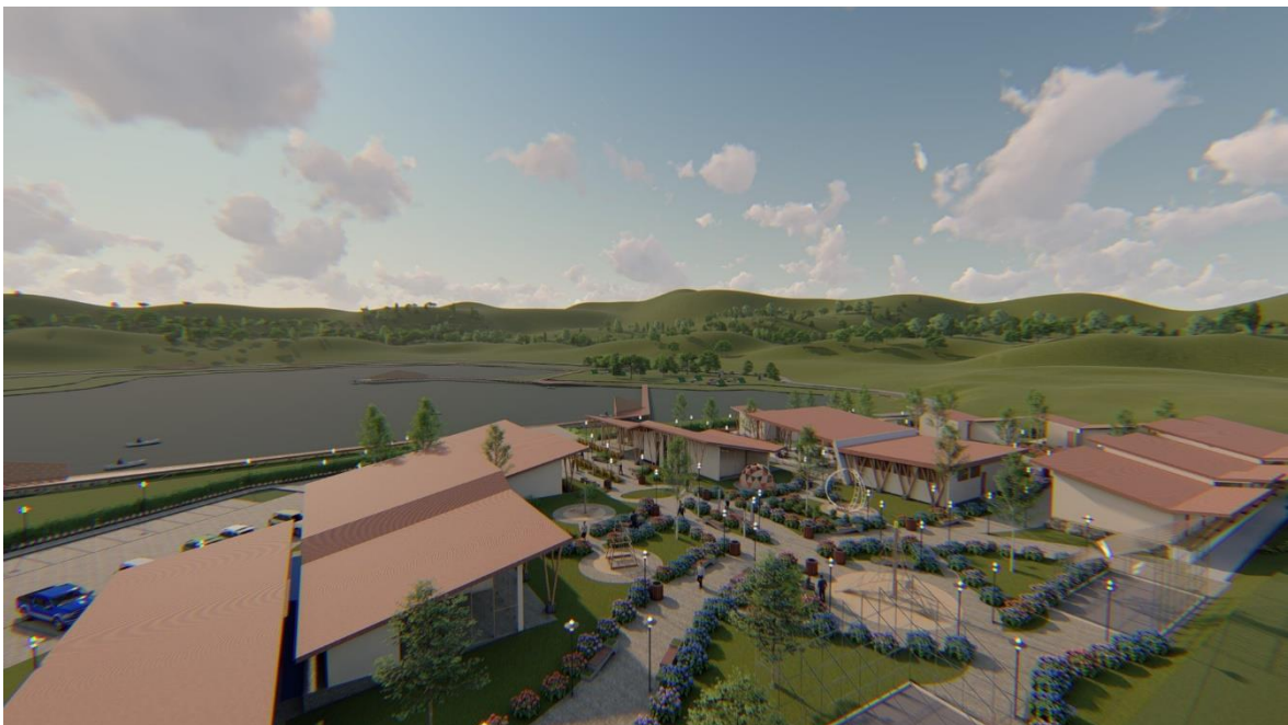
Figura 4.23. Vista a vuelo de pájaro – esquina sur oeste.
