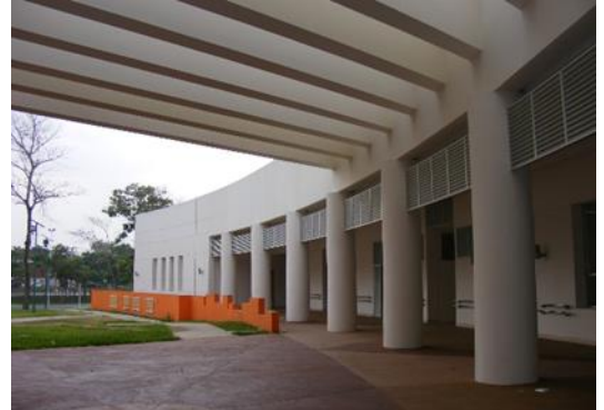
Imagen: Vista desde patio interior Fuente:
