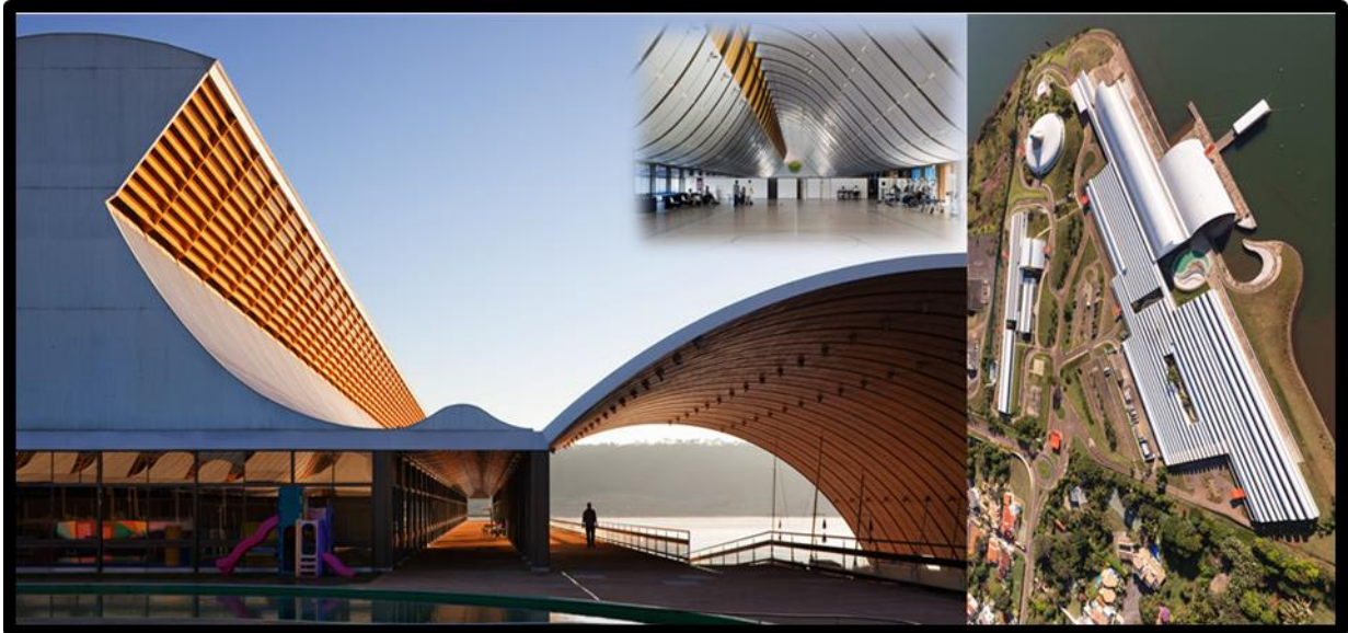
Figura 26: Centro de Rehabilitación Sarah Kubitschek
