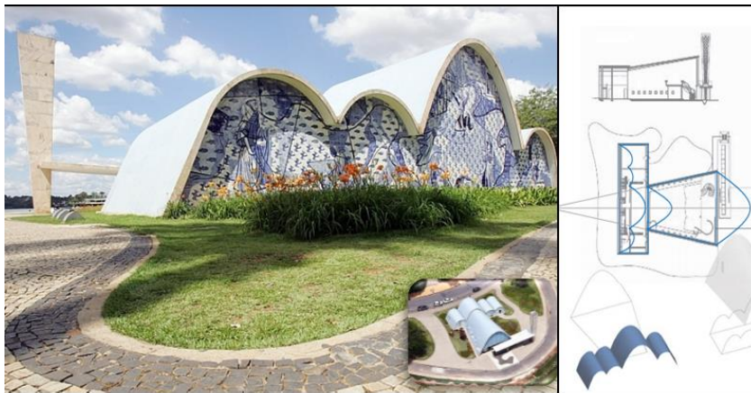
Figura 14: Cubierta cilíndrica de base parabólica de la iglesia San Francisco de Asís
