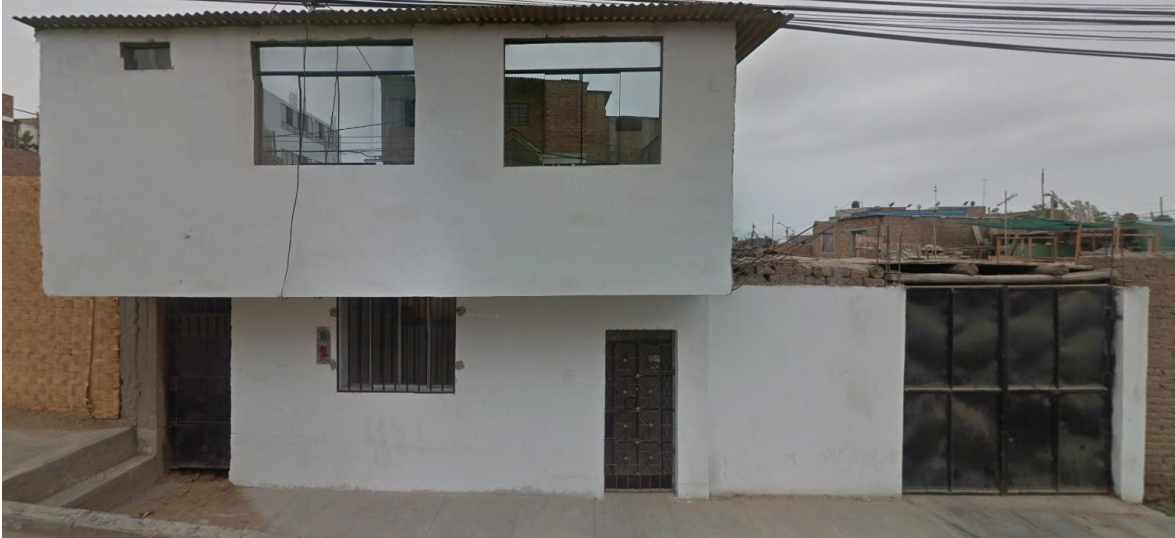
Figura 103: Centro de rehabilitación REMAR – Florencia de Mora
