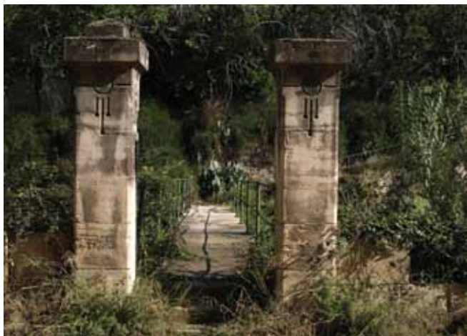
Fig. 28: passarel·la de vianants per a accedir a l'estenedor de la fàbrica L'escaló
