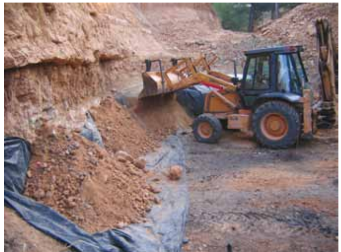
Fig. 10: cubrimiento con escombro del frente de excavación para evitar expolios.
