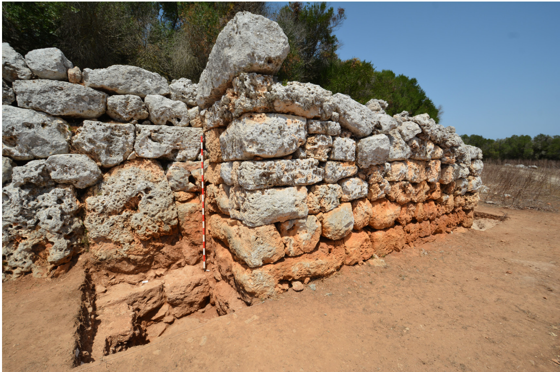
Figura 4. Sondeo diagnóstico realizado en la torre norte en 2017. Se observa la zapata y el lienzo original (s. VI a. C.) y la torre adosada (s. III a. C.). Fotografía: Proyecto Modular.
