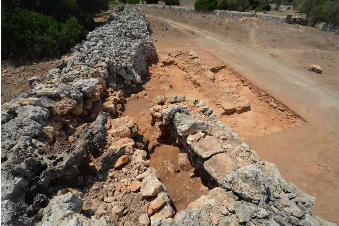
Figura 8. El parapeto y la garita/casamata lateral al final de la campaña de 2017. Fotografía: Proyecto Modular.
