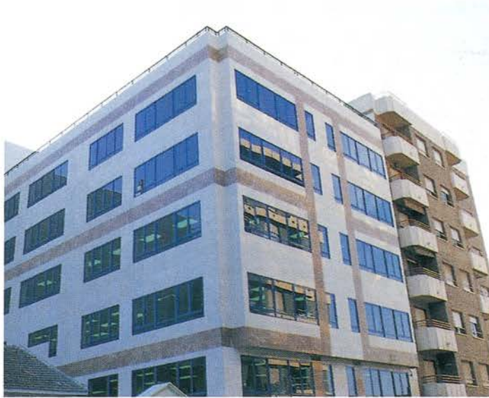
Edificio de las oficinas de Aguas de Alicante. Grupo Agbar.
