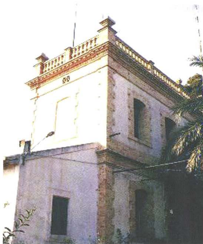
Depósito de los Ángeles, construido a finales del S. XIX.
