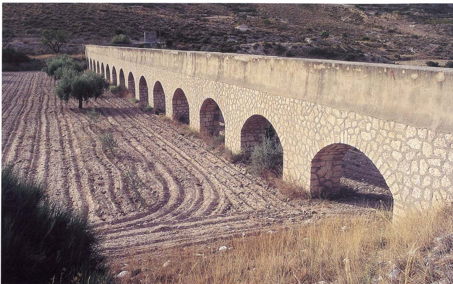
Acueducto del Canal del Cid (foto F. Albert y E. Ortiz).
