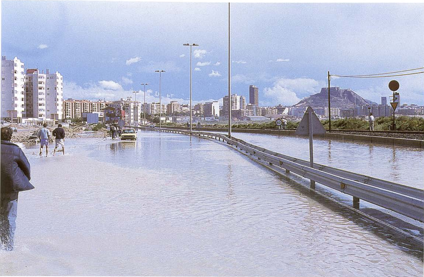
Inundación de septiembre de 1986, efectos en la carretera de Alicante-Murcia.
