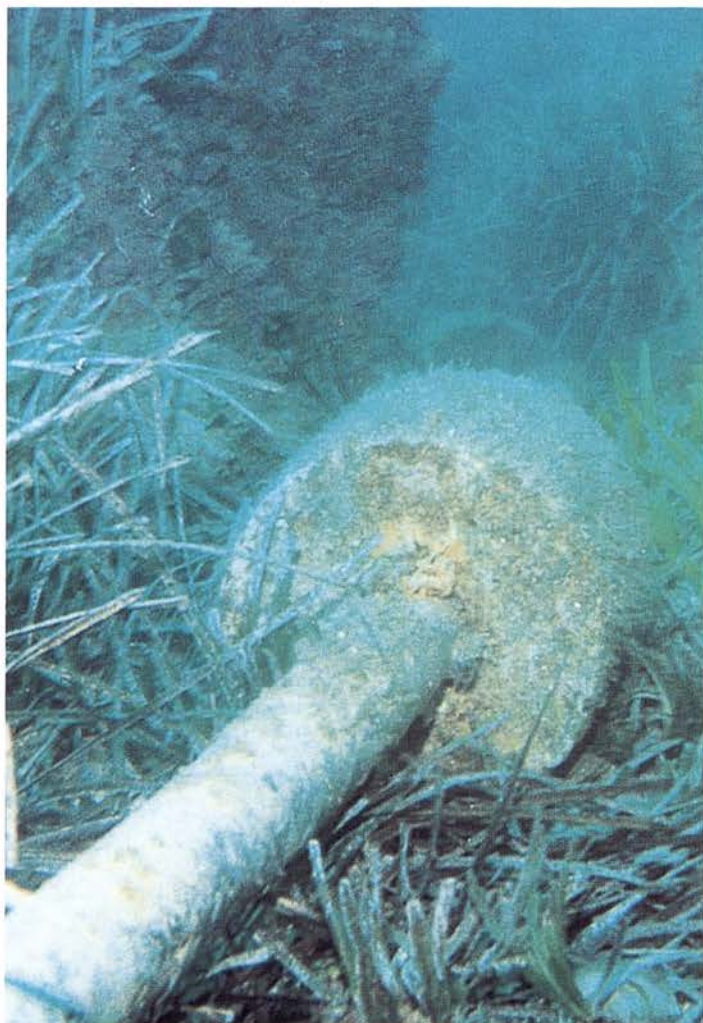
Conducción submarina a la Isla de Tabarca.
