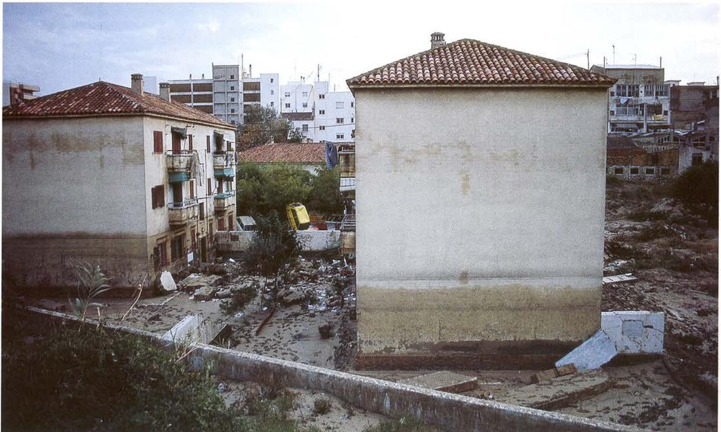
Impacto de la Riada sobre las casas de la RENFE situadas en pleno cauce del antiguo barranco de San Blas-San Agustín.
