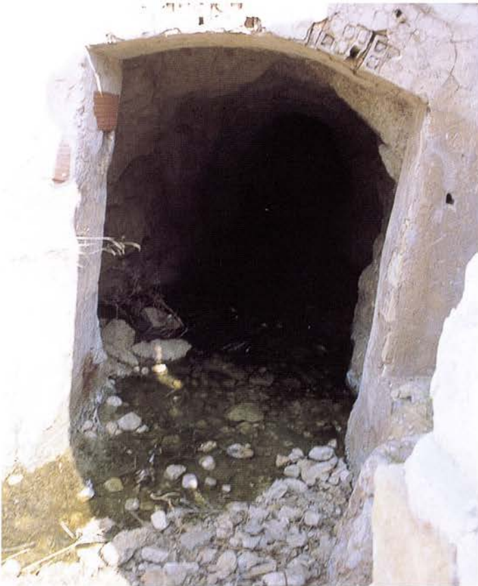
Acueducto perteneciente al minado de la "Font Antigua de Crevillente".
