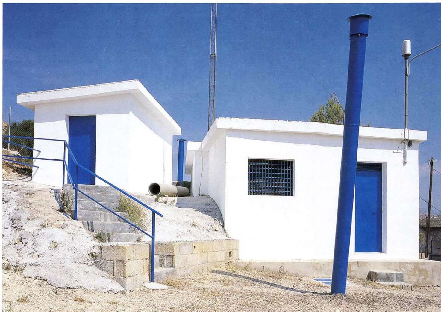
Casetas del centro de control de distribución de Aguas de Alicante en el medio Vinalopó.
