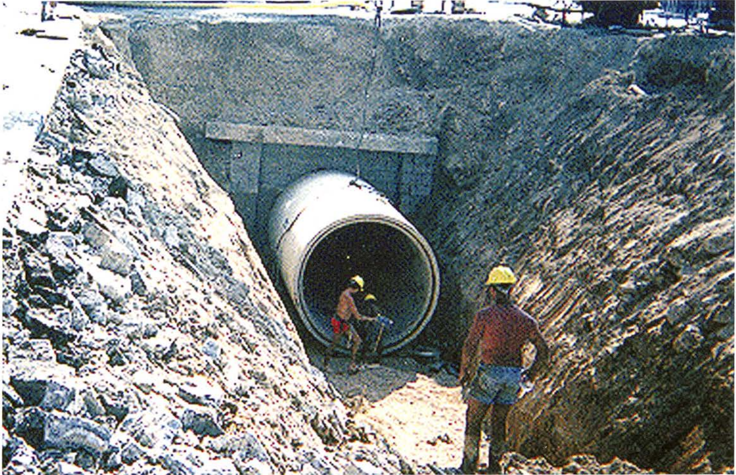
Obras comprendidas en el plan de emergencia contra inundaciones.
