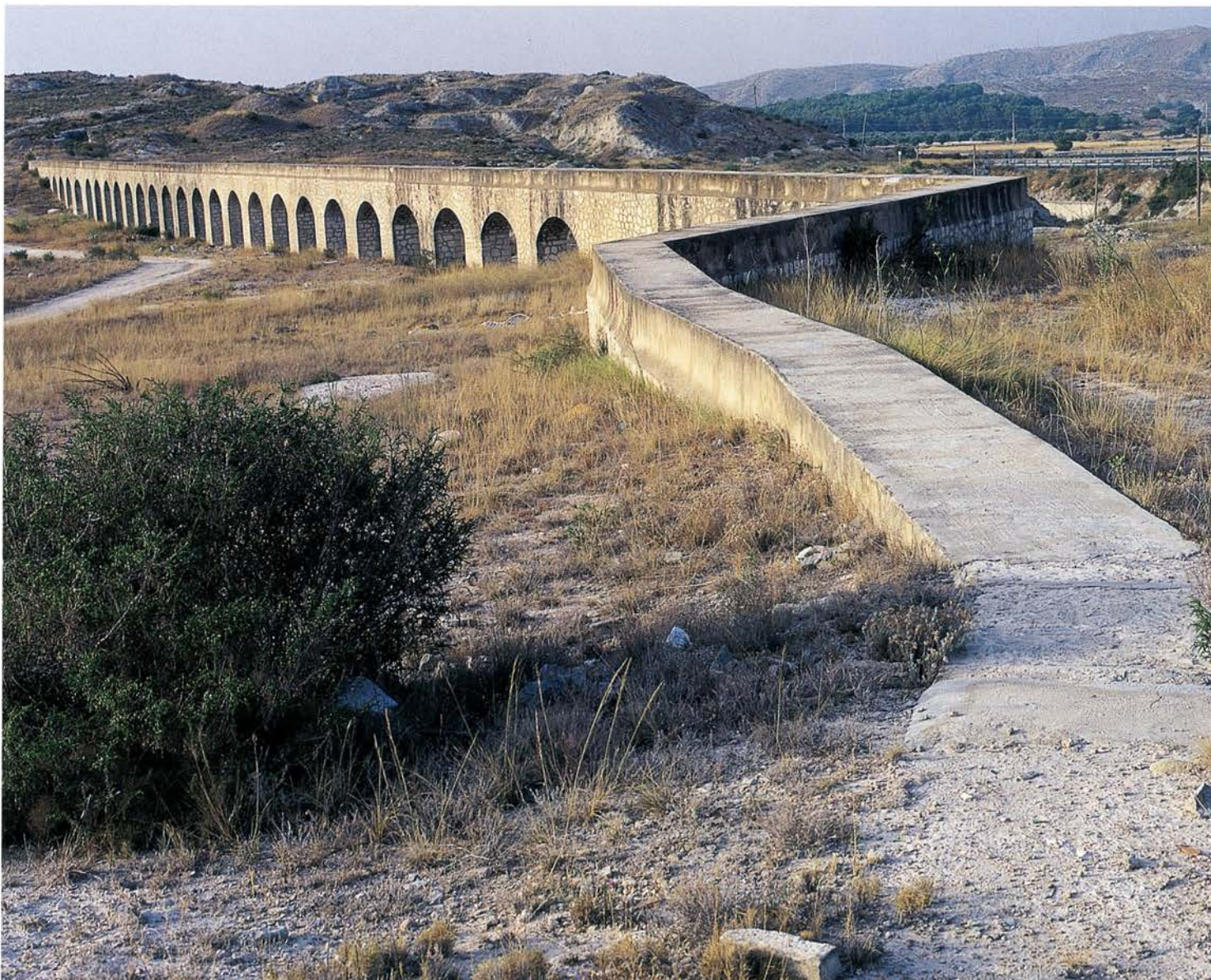
Acueducto del Canal del Cid (foto F. Albert y E. Ortiz).
