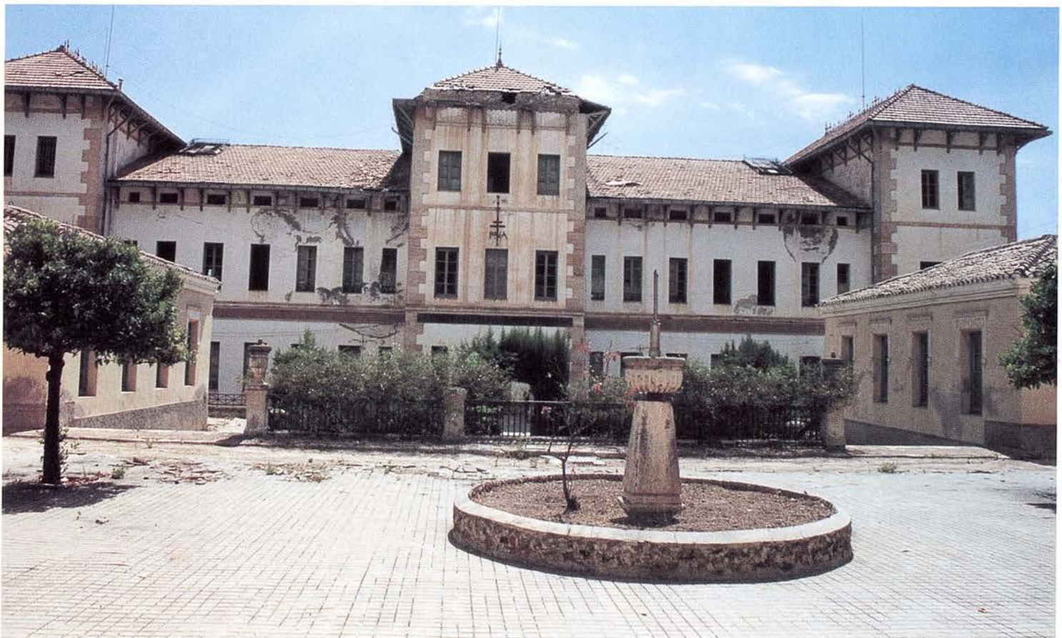
Baños de Busot (estado actual).
