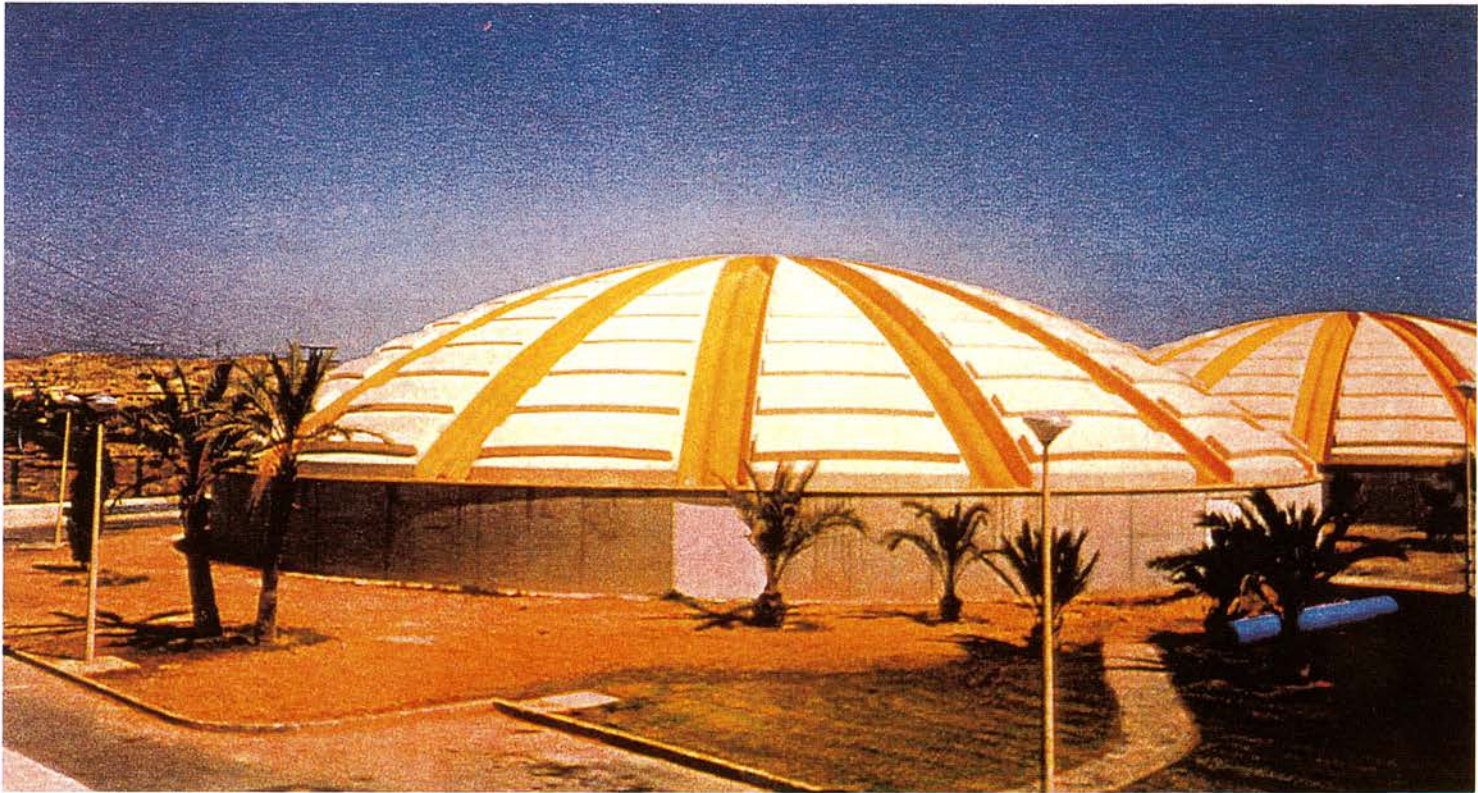
Vista general de las cúpulas de llos decantadores primarios. EDAR Orgegia, 1998.
