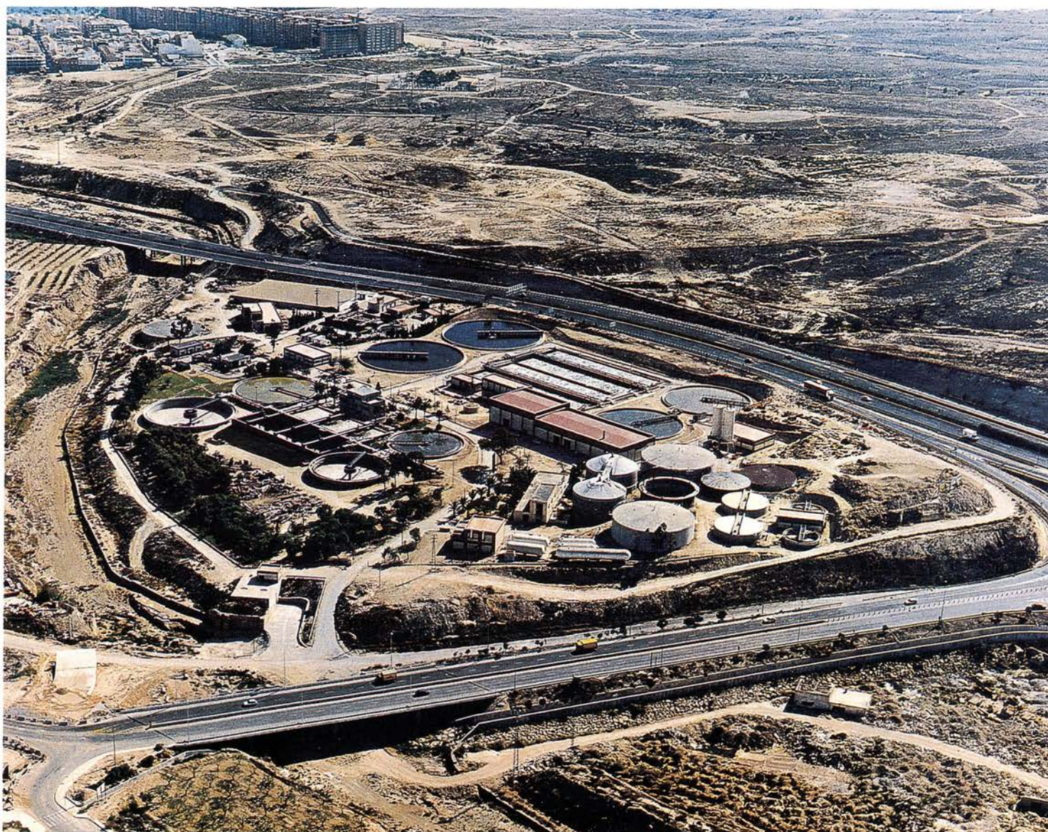
Vistas generales de las obras de ampliación. EDAR Rincón de León (septiembre, 1998).
