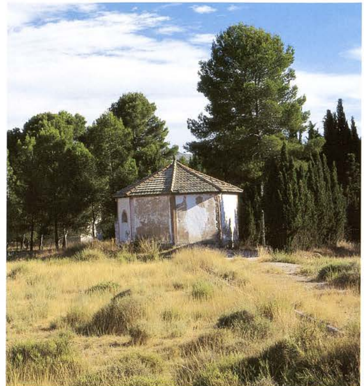
Imagen exterior del pozo en los Prados de Sax (foto F. Albert y E. Ortiz).
