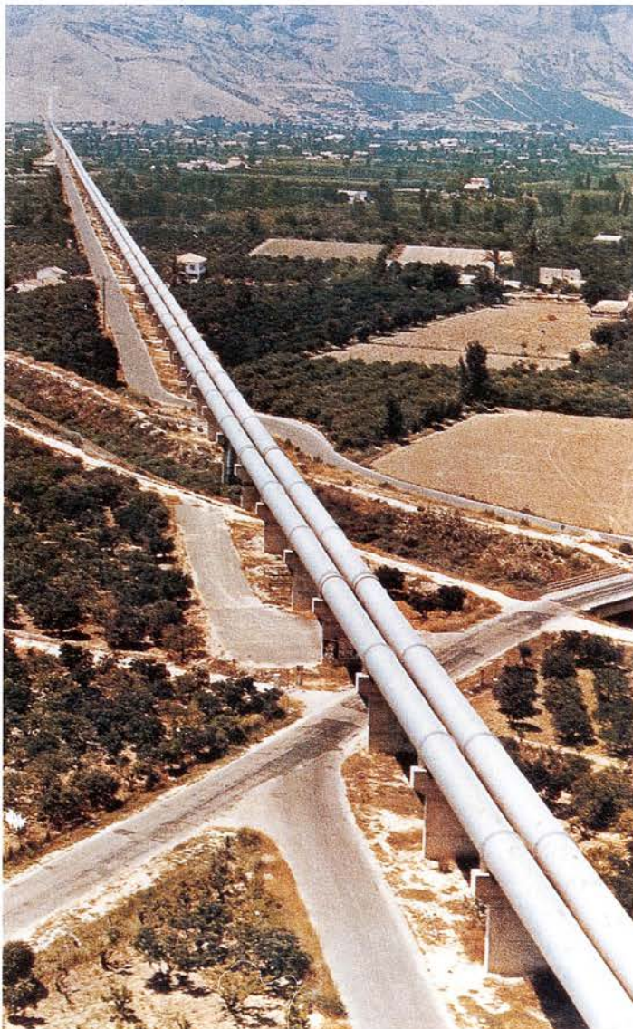
Infraestructura del Trasvase Tajo-Segura.
