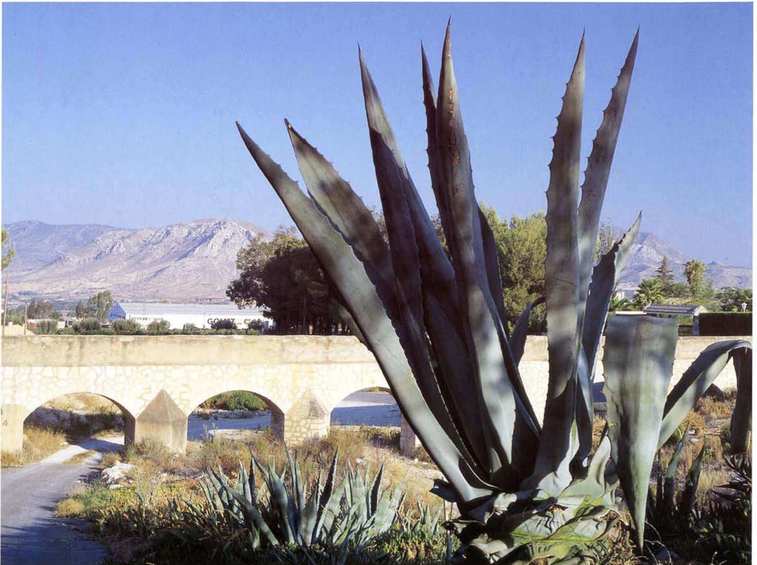
Canal de traída de Aguas de Sax (foto E. Ortiz y F. Albert).
