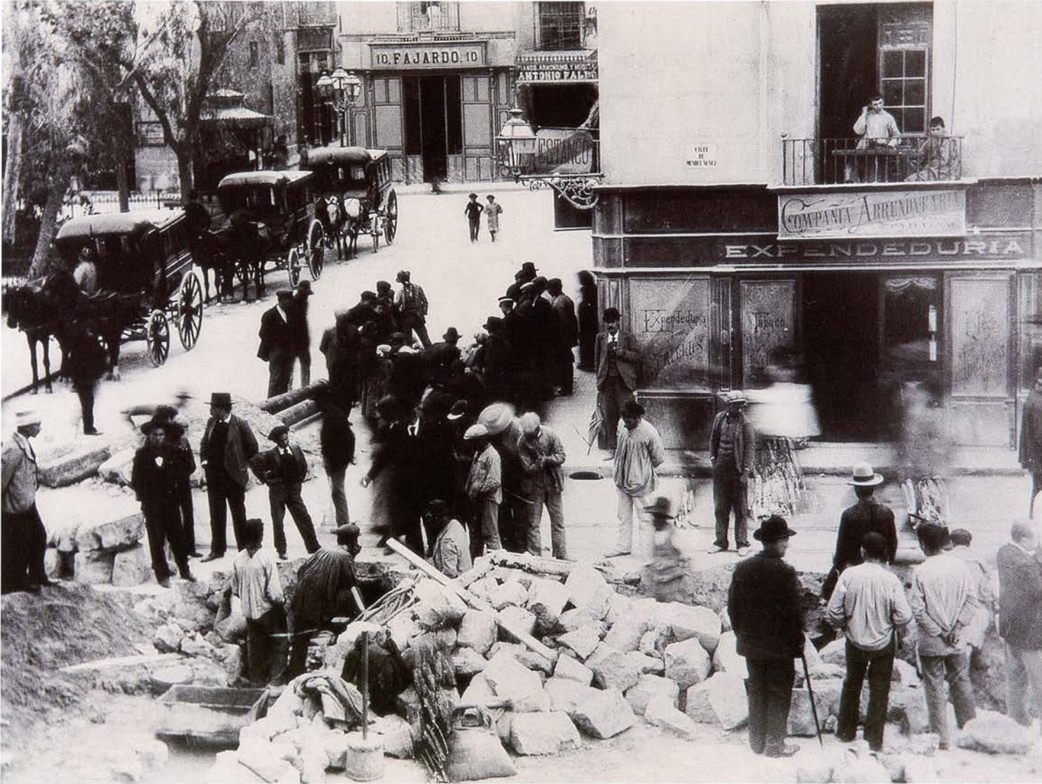
Obras para el abastecimiento de aguas a Alicante en la calle de Méndez Núñez a finales del siglo XIX (Cantos).
