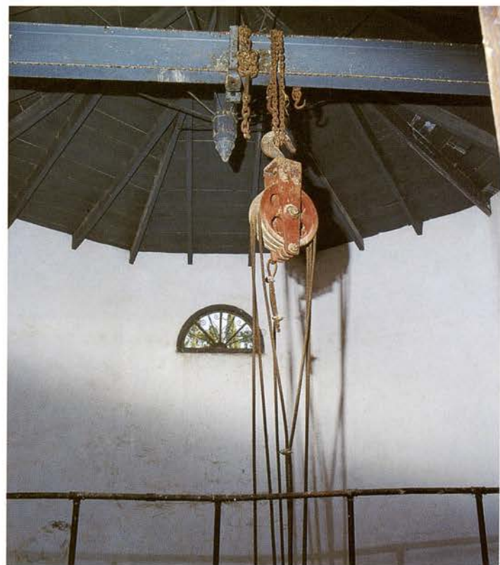
Cúpula y sistema de poleas en el interior de los Pozos de Sax, contruidos en la década de los setenta del siglo XIX. (Foto E. Ortiz y F. Albert).
