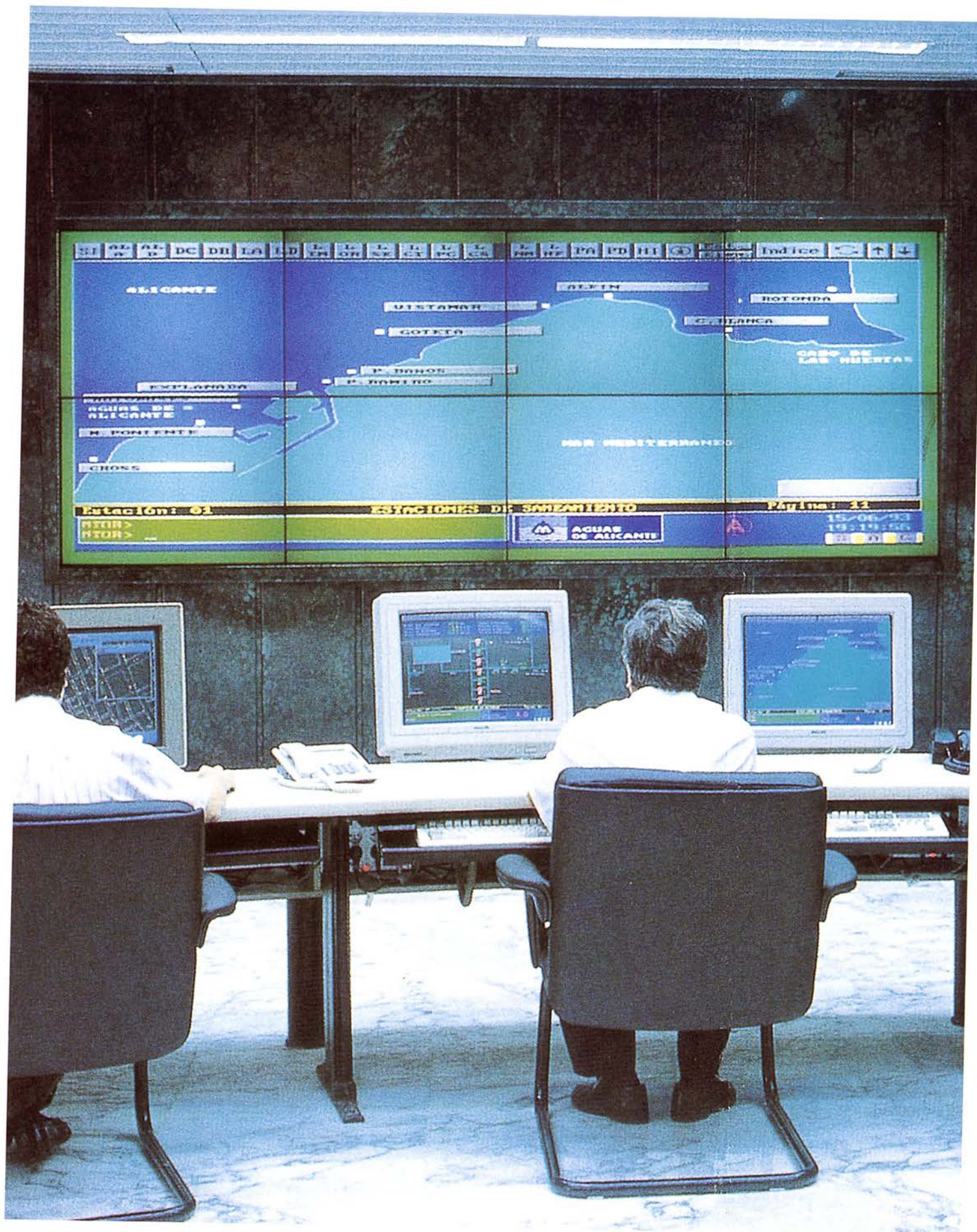
Área de telemando en Aguas de Alicante.
