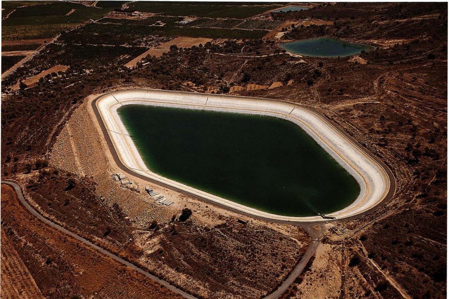
Aspe. Depósito regulador de fibra plástica. Estas infraestructuras hidráulicas cubren una buena parte de los regadíos de la zona, constituyendo uno de los pilares básicos del sistema de riego y de la viabilidad de las explotaciones.
