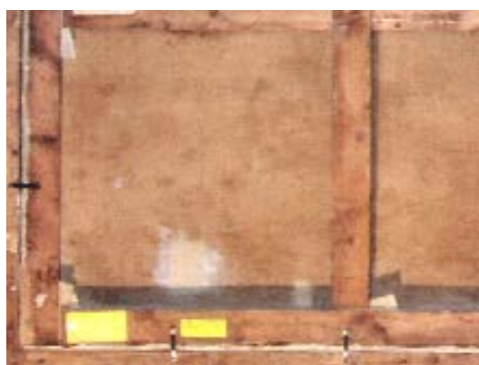
e - Detall de l'encaix francès amb dobles falques.
