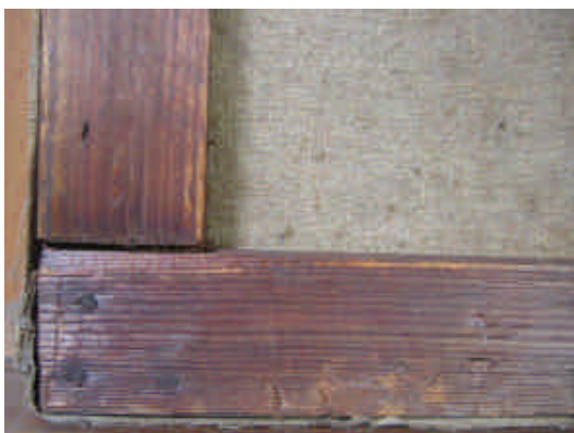
c - Detall de l'encaix fix amb claus de ferro del bastidor.
