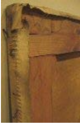
a - Detall de la tela marcada per les tenalles del muntatge.
