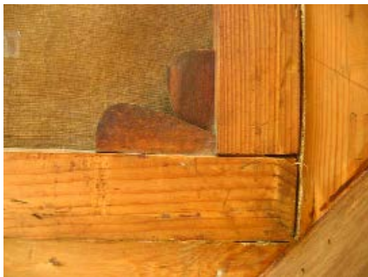
b - Detall del tipus d'encaix francès amb doble falca.
