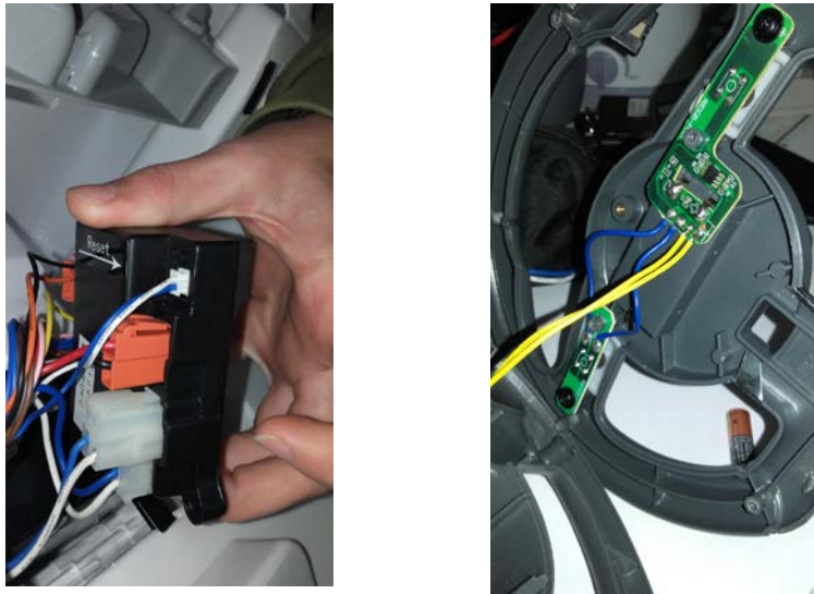
Fig. 2. Instalaciones eléctricas y electrónicas
