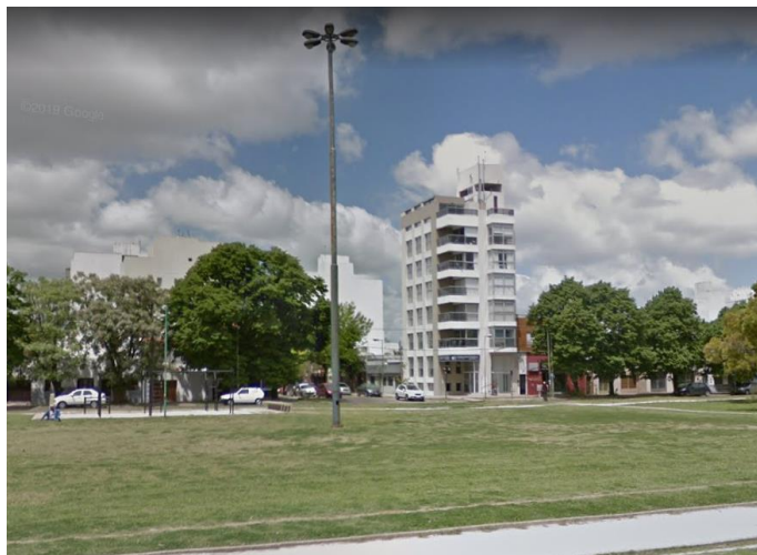
Imagen 18. Rambla de avenida circunvalación. Fotografías de la autora 2014
