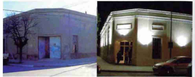
EDIFICIO USINA EN OBRA
