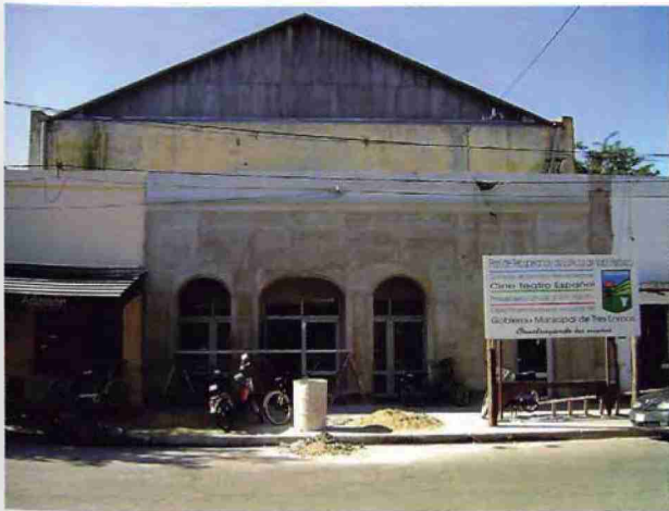
CENTRO CULTURAL ESPAÑOL EN OBRA
