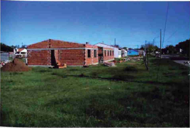
CONSTRUCCIÓN DE VIVIENDAS
