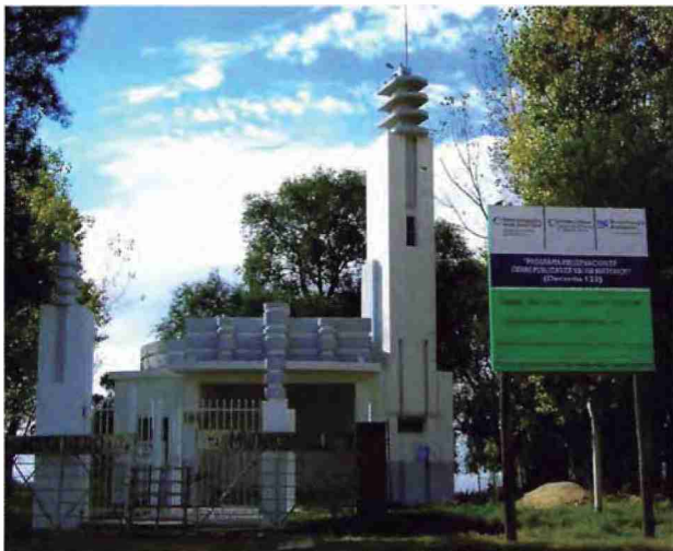
MATADERO MUNICIPAL EN OBRA
