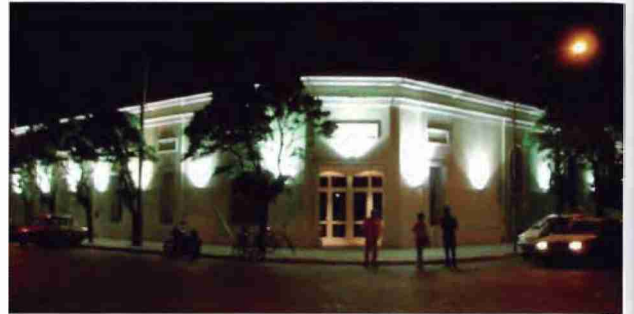
EDIFICIO USINA - CENTRO CULTURAL LA VIEJA USINA
