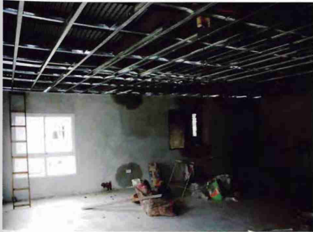
OBRA DEL SALÓN BLANCO MUNICIPAL
