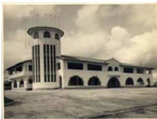
Imagem 7. Prédio do comando da Base Aérea de Cumbica – São Paulo. (Fonte: Acervo do Museu Aeroespacial)
