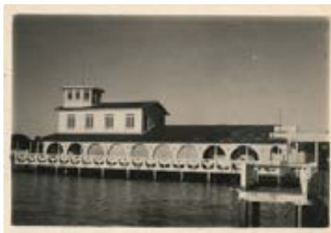
Imagem 3. Terminal de passageiros do aeródromo Rampa. (Fonte: Acervo do Museu Aeroespacial)
