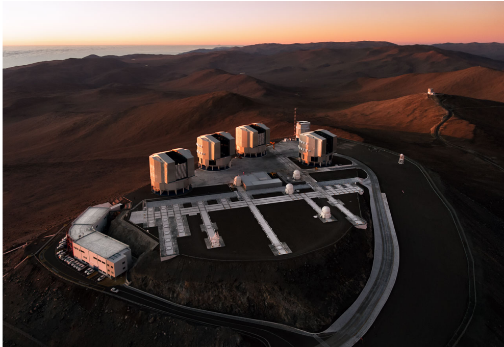
Figura 8.1: VLTI - Posiciones de los UTs y bases para los ATs. La máxima línea de base (200 m) es la formada al combinar los ATs en las bases B5 y J6 (Fuente: www.eso.org).
