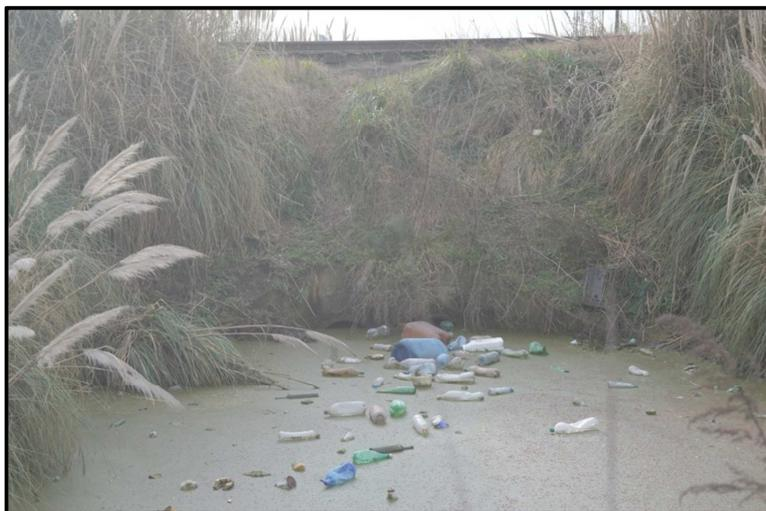
*Foto 4-5: Alcantarilla bajo vías del ferrocarril*
