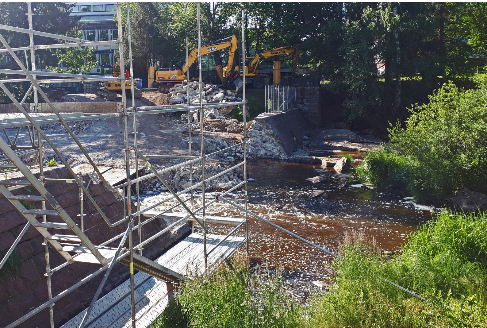
Kuva 10. Tikkurilankosken padon purku Vantaalla palautti luontaisen virtavesiekosysteemin. Padon purku on hyvä esimerkki toimivasta ekologisesta kompensatiosta virtavesissä. Kuva: Saija Koljonen.
