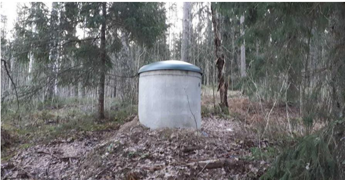
Kuva 7. Asemille LAUT ja KUNI asennettiin uusi lujitemuovinen lisäkansi, koska kannessa ollut luukku ei ollut riittävän tiivis. Kuvassa on KUNI-asema.
