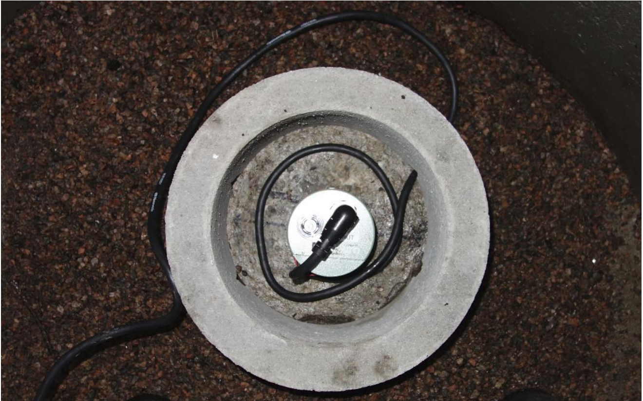
Kuva 4. Kaivonrenkaan sisällä on betonilieriö, jossa seismometri. Tämä kuva on LAUT-asemalta, mutta seismometri on suojattu samalla tavalla kaikilla HelsinkiNet-aseilla.
