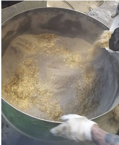
Obrázok 4 Pridávanie ocelových vlákien do betónu [autor]
