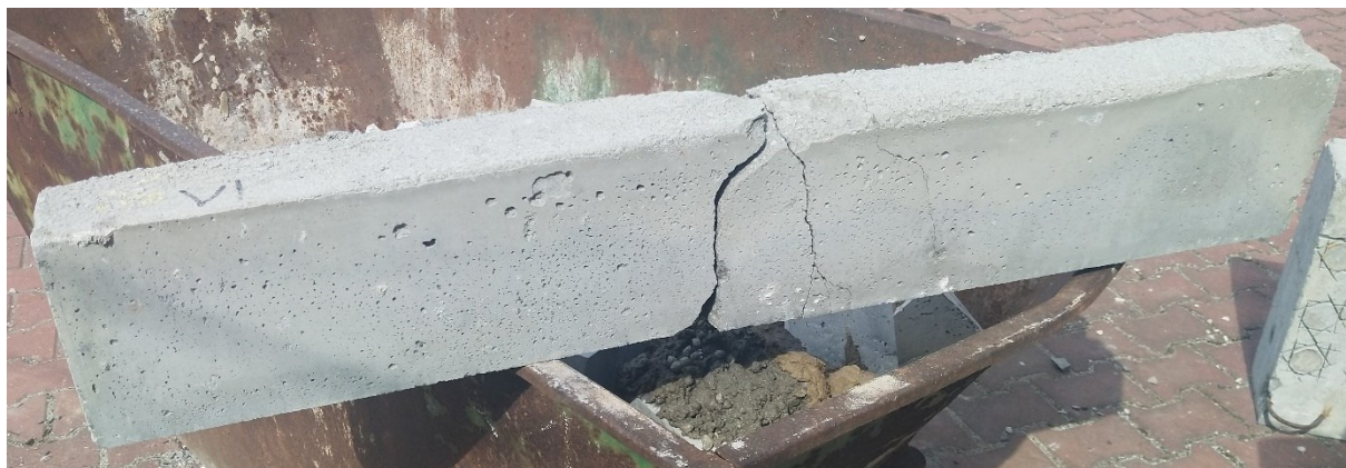
Obrázek 16: Nosník délky 1150 mm a průřezu 190x100 mm, výztuž 2x6 mm, rozpětí 900 mm, porušení tahem + smykem, zdroj: vlastní
