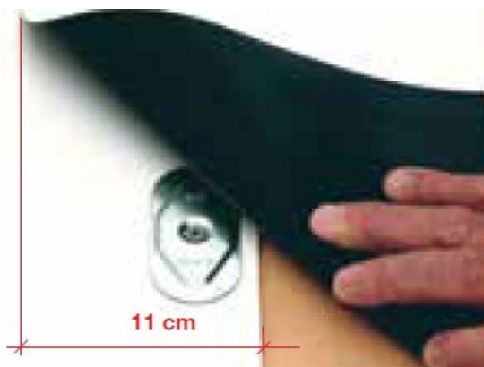
Obrázek 18 - Přesah fólie [25]
