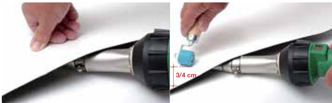
Obrázek 23 - Ruční bodové svařování [25]
