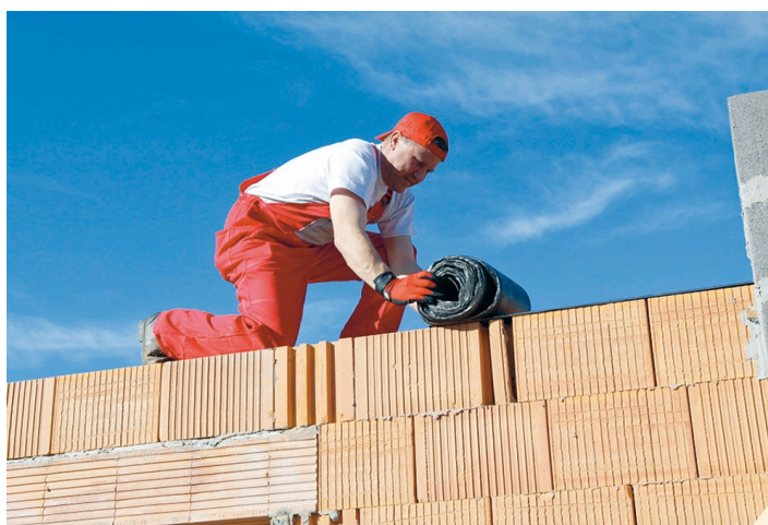
Obrázek č.9 – Pokládka asf. pásů [29]
