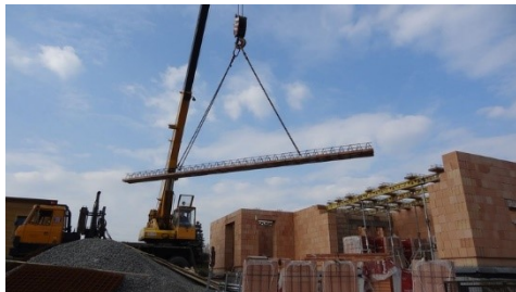
Obrázek č.10 – Pokládka stropních trámů Porootherm [30]
