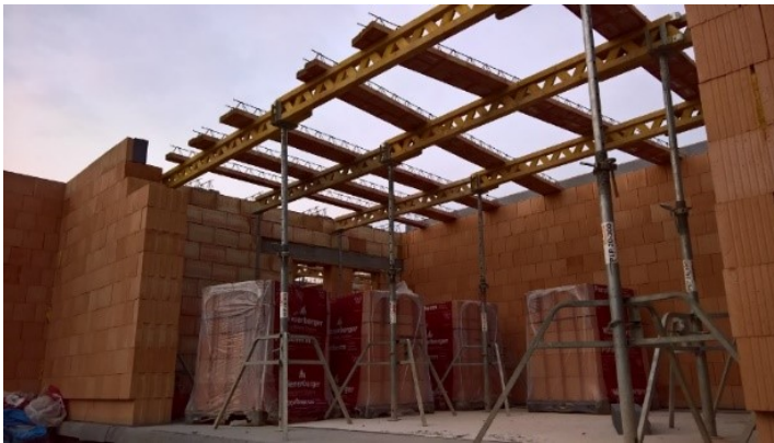
Obrázek č.12 - podepření stropu [31]
