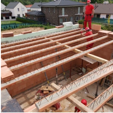
Obrázek č.1 – Uložení stropních trámů [22]
