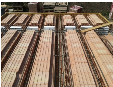
Obrázek č.6 – Strop Porotherm včetně výztuže [26]
