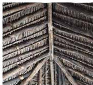
Figure 13. Copertura a “*par e hilera*”.
