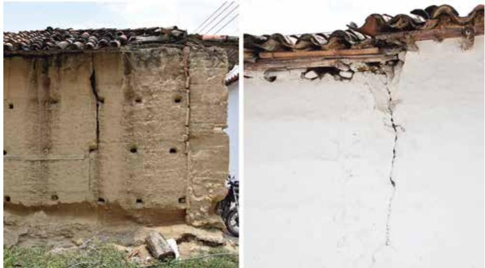
Figure 23. Pareti spovviste di ammorzamento con conseguenti danni strutturali – Cepitá.
