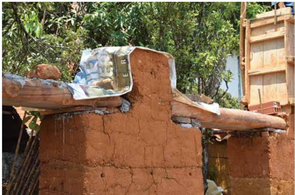
Figure 21. Fase realizzativa di un architrave, Barichara.
