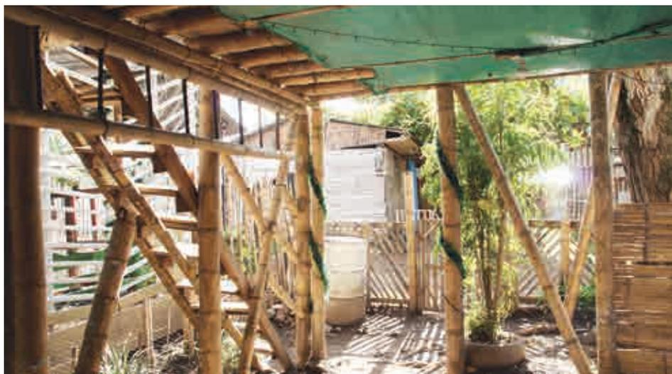
Tra le criticità strutturali, definite come errori di disegno o assenza di un progetto specifico, si annoverano: assenza delle fondazioni, mancanza di connessione e ammortamento
