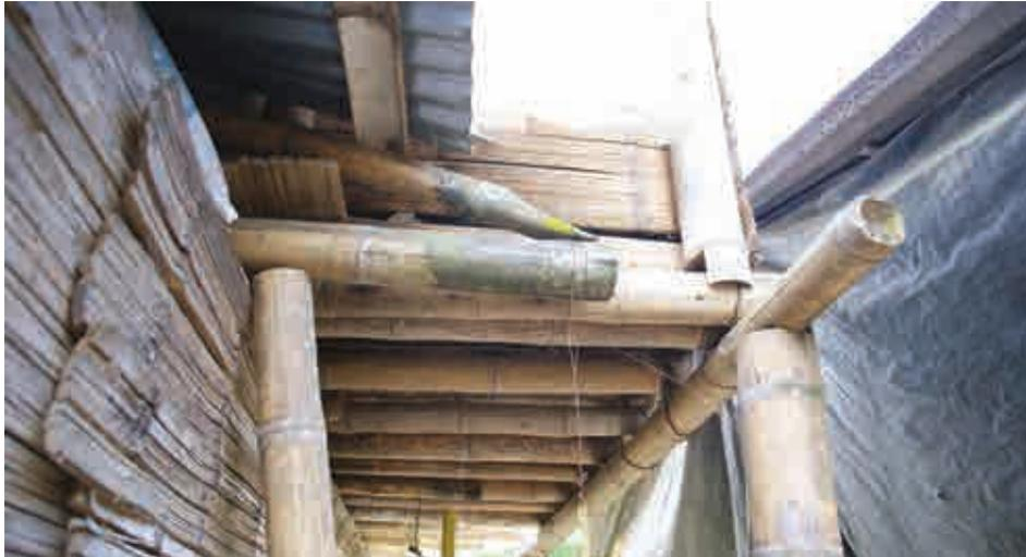
Figure 13. Errori di disegno e di collegamento degli elementi a sbalzo
