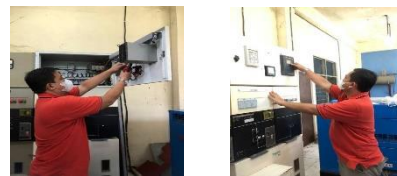
Gambar 4. Proses pemasangan Meter, Relay SEPAM dan Relay Micom
