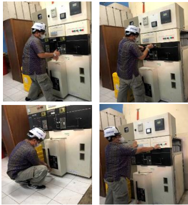
Gambar 6. Pengujian mekanik kubikel
