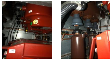
Gambar 3. Wiring CT dan PT
