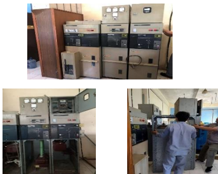
Gambar 2. Proses pembongkaran kubikel lama
