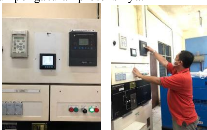
Gambar 8. Pengujian Relay dan metering
