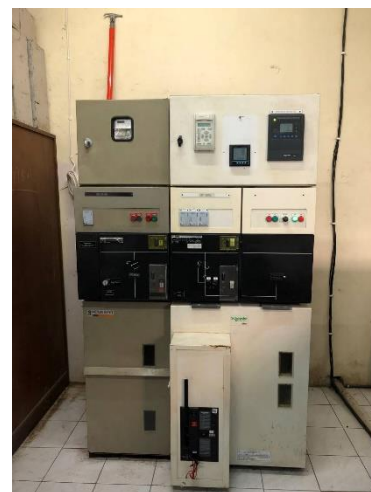
Gambar 4. Proses pemasangan Meter, Relay SEPAM dan Relay Micom
