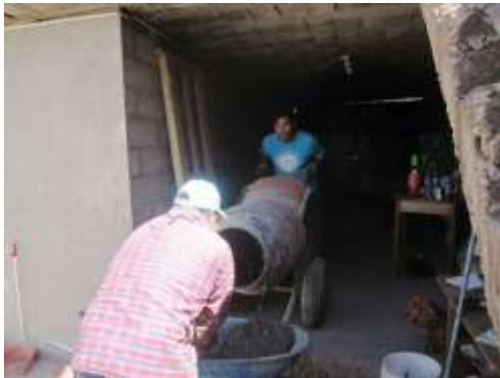
Figura 53: Preparación del concreto en mezcladora.
