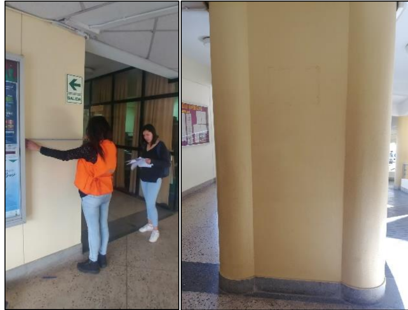
Figura 35: Contratación de dimensiones de principales elementos estructurales en campo
