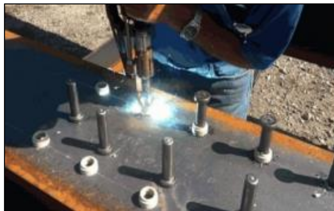
Figura 10: Colocación de pernos soldados
