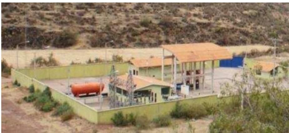
Fotografía N° 4 Estación de Bombeo de Rumicolca
