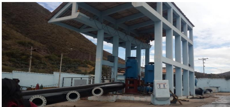
Fotografía N° 6 Estación de Bombeo de Qollana
