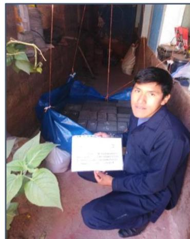
*Figura 67: Curado de adoquines en una mini piscina de plástico*
