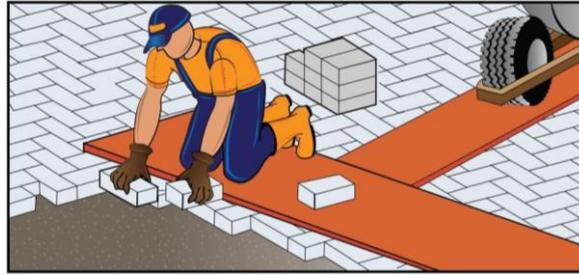
*Figura 10: Instalación de los adoquines*
