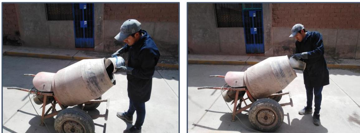
*Figura 62: Colocado de materiales en máquina mezcladora tipo carretilla*
