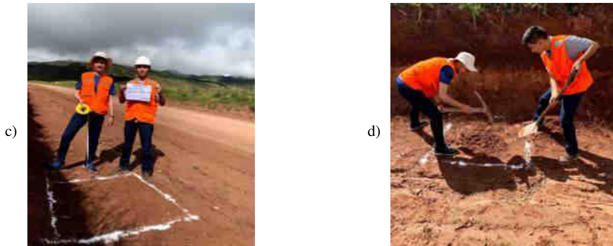
Figura 20: Calicata N°03-km 05+430 “c)”, Calicata N°04-km 06+120 “d)”
